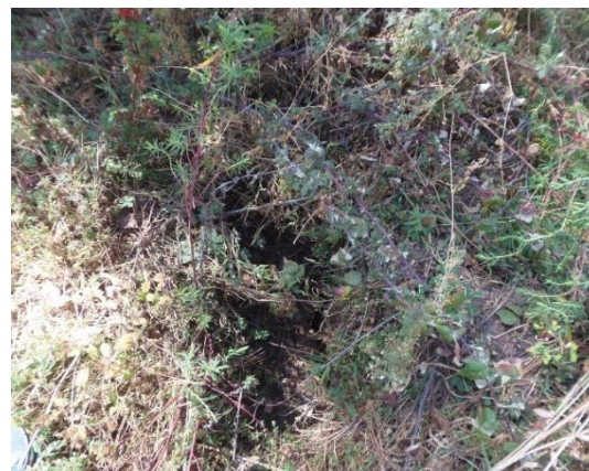
Figura 60. Azolve de las zanjas de infiltración en los tres sitios de estudio (2015).
