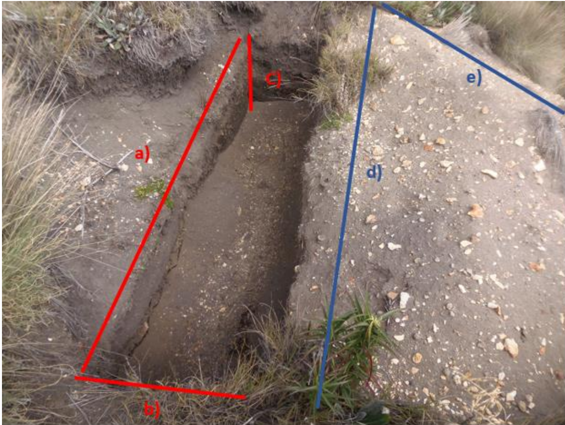
Figura 32. Medición de las dimensiones de las zanjas de infiltración y de los bordos: a) longitud de la zanja; talud frontal al bordo b) ancho de la zanja; cara lateral de la zanja c) profundidad de la zanja, d) ancho del bordo; talud de bordo y e) largo del bordo.
