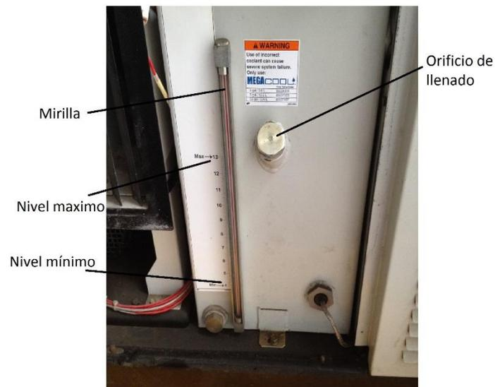
Figura 38) Depósito de refrigerante de la turbina.
