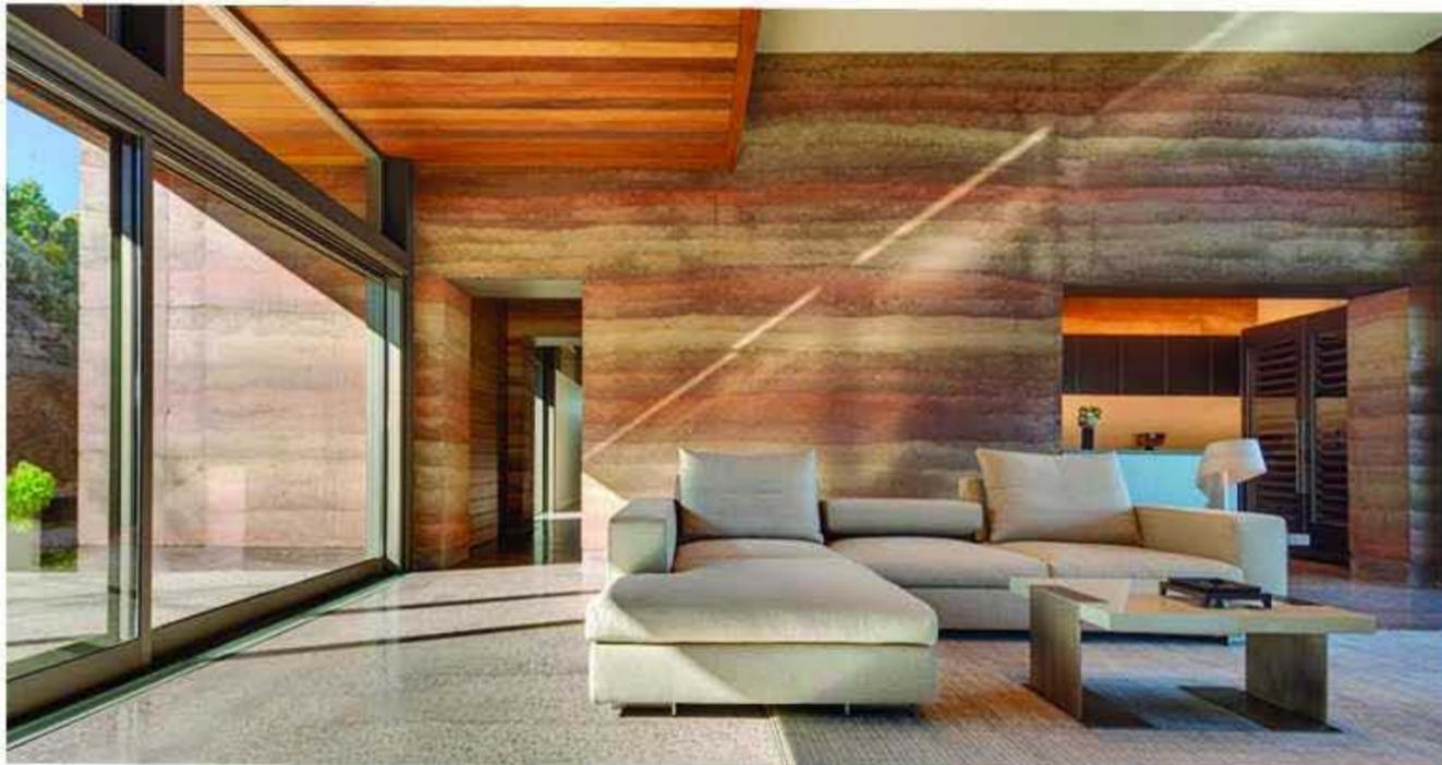
*Img. Vivienda hecha con el sistema constructivo de tapias. fuente <http://hombresdemaiz.com.mx/v2/wp-content/uploads/2014/11/la-compresión-de-la-tapia> hasta terminarse cada bloque.”<sup>23</sup>*
