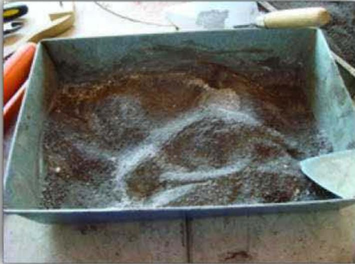
**Img. Mezcla de los agregados.**
