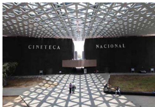
Plaza de transición entre edificio original y el complejo reciente
