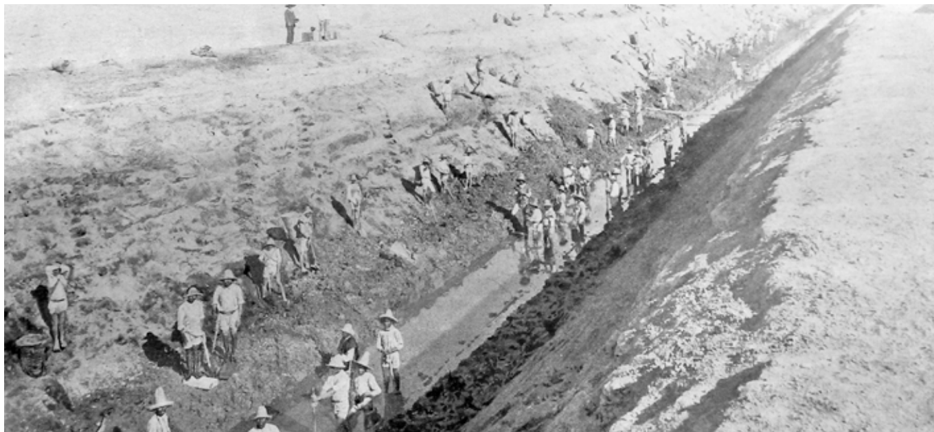
Fig 2.2 Excavación para la construcción del Gran Canal de Desagüe.
