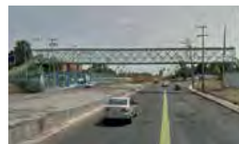
Fig 2.53. Puente peatonal- PP2
