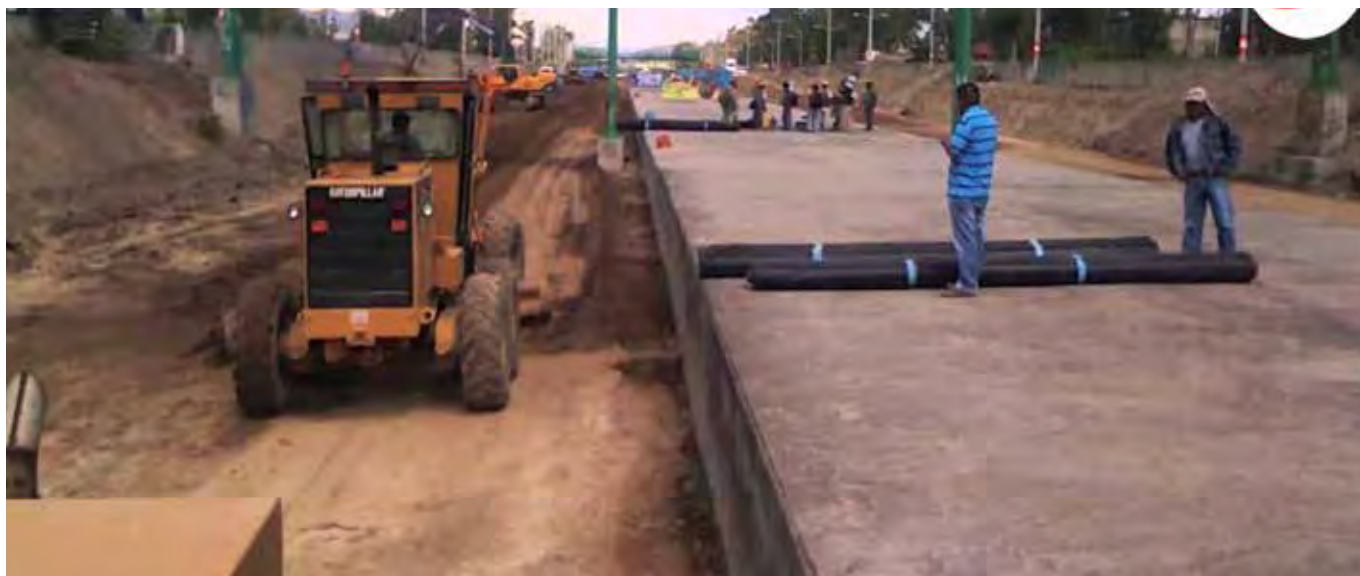
Fig 2.3 Pavimentación para la construcción de la Avenida Gran Canal.
