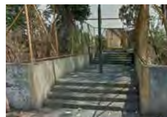
Fig 2.55. Puente peatonal- PP8
