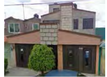
Fig 4.9. Vivienda aleatoria tomada de la colonia San Pedro el Chico. Tres niveles, acabados de mampostería decorativa, yeso y pintura texturizado.
