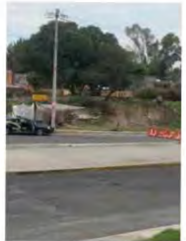
Fig 4.14. Se colocan barreras viales de plástico para limitar la avenida a dos carriles y de esa manera hacer un poco más seguro el cruce de peatones, además de una patrulla que vigila el exceso de velocidad de los conductores.
