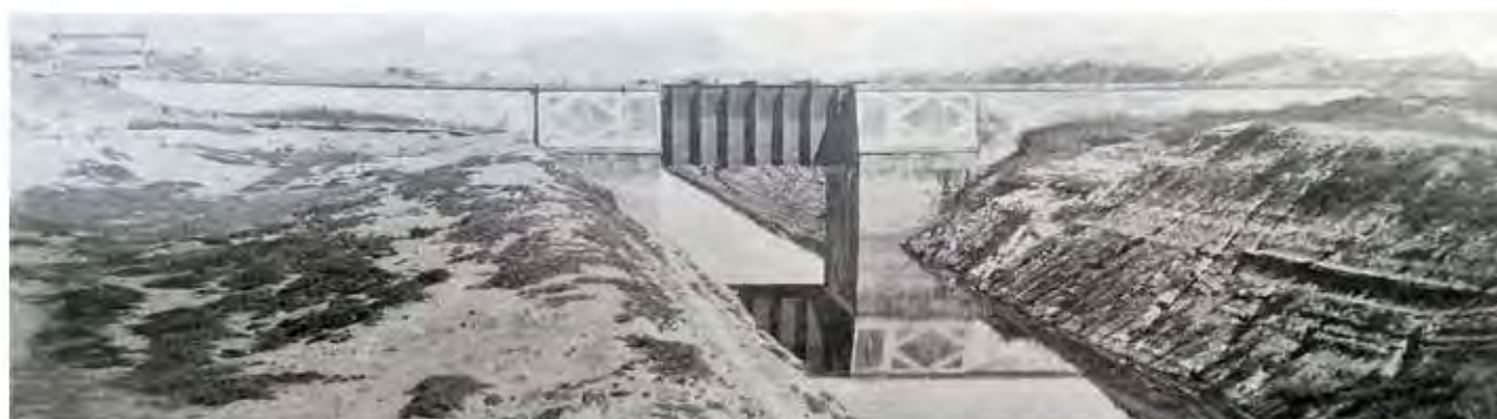
Fig 2.16 Gran Canal: Puente acueducto del Río Guadalupe, kilómetro 6, en 1983
