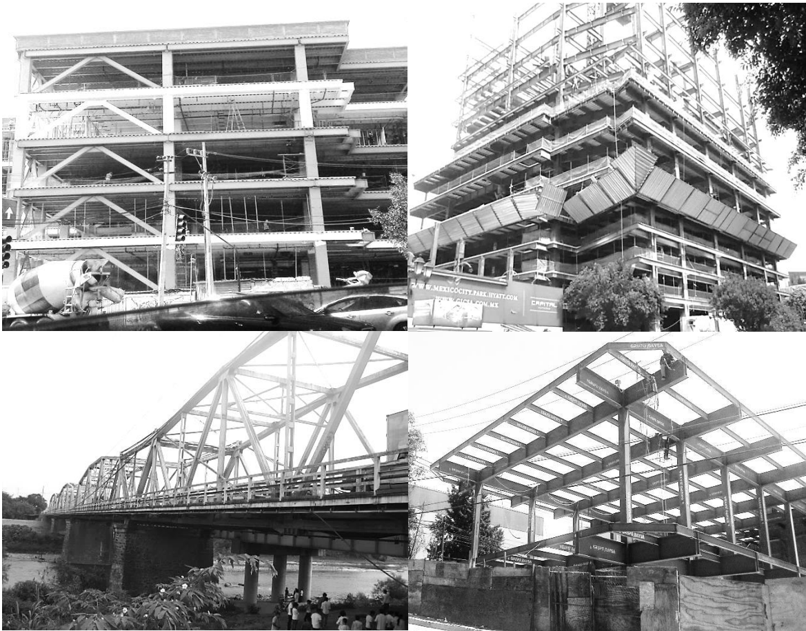
Fig. 1.A Estructuras reticulares y marcos rígidos.
