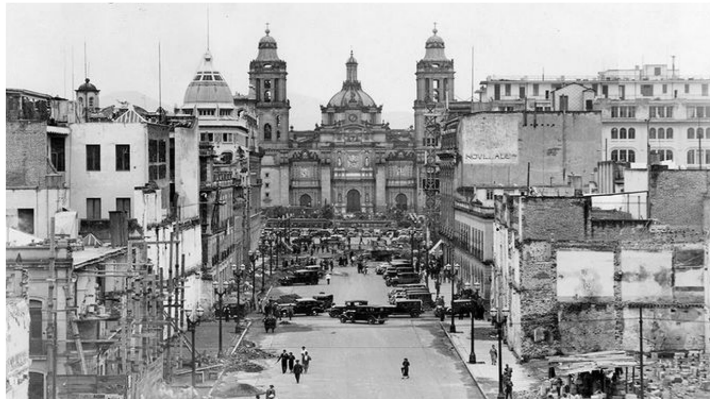
Ampliación Avenida 20 Noviembre - 1933
