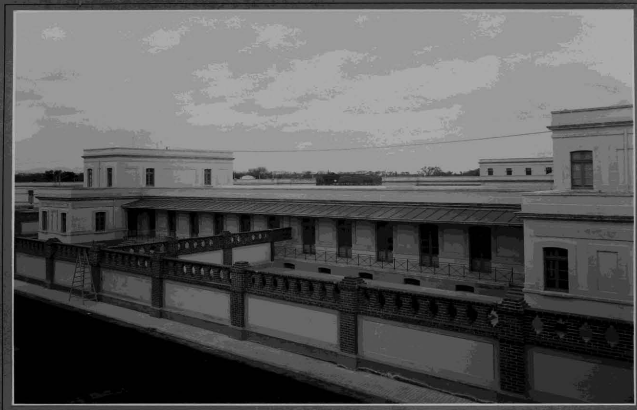
Hospital General : Departamento de infecciosos. Pabellón de fiebre puerperal.
