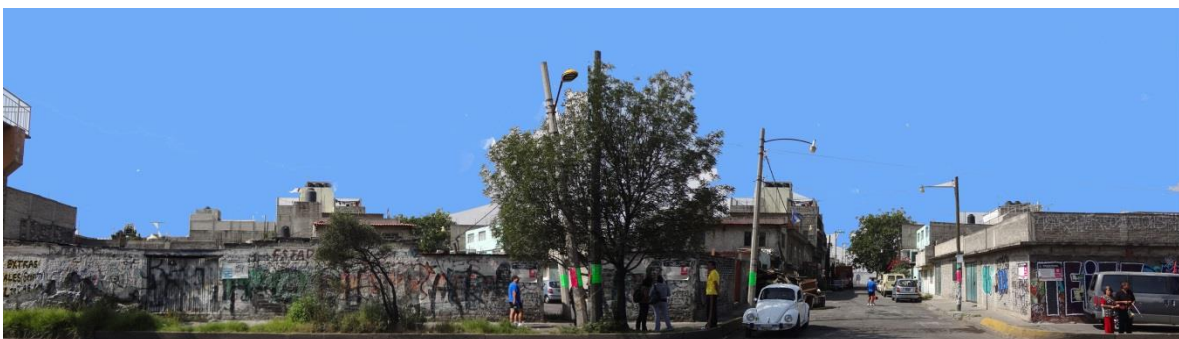
Figura 58. Tipología de vivienda 2.
