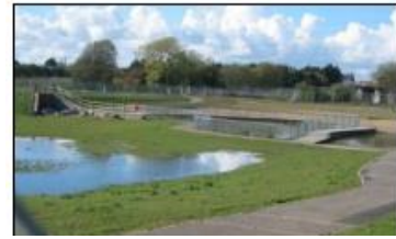
Figura 24. Depósitos de infiltración. 39
