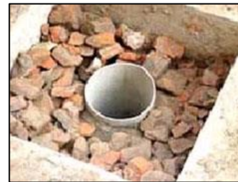
Figura 21. Pozos y Zanjas de Infiltración. 36
