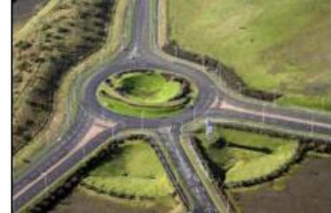
Figura 25. Depósitos de Detención en Superficie. 40
