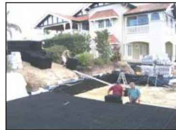
Figura 26. Depósitos de Detención Enterrados. 41
