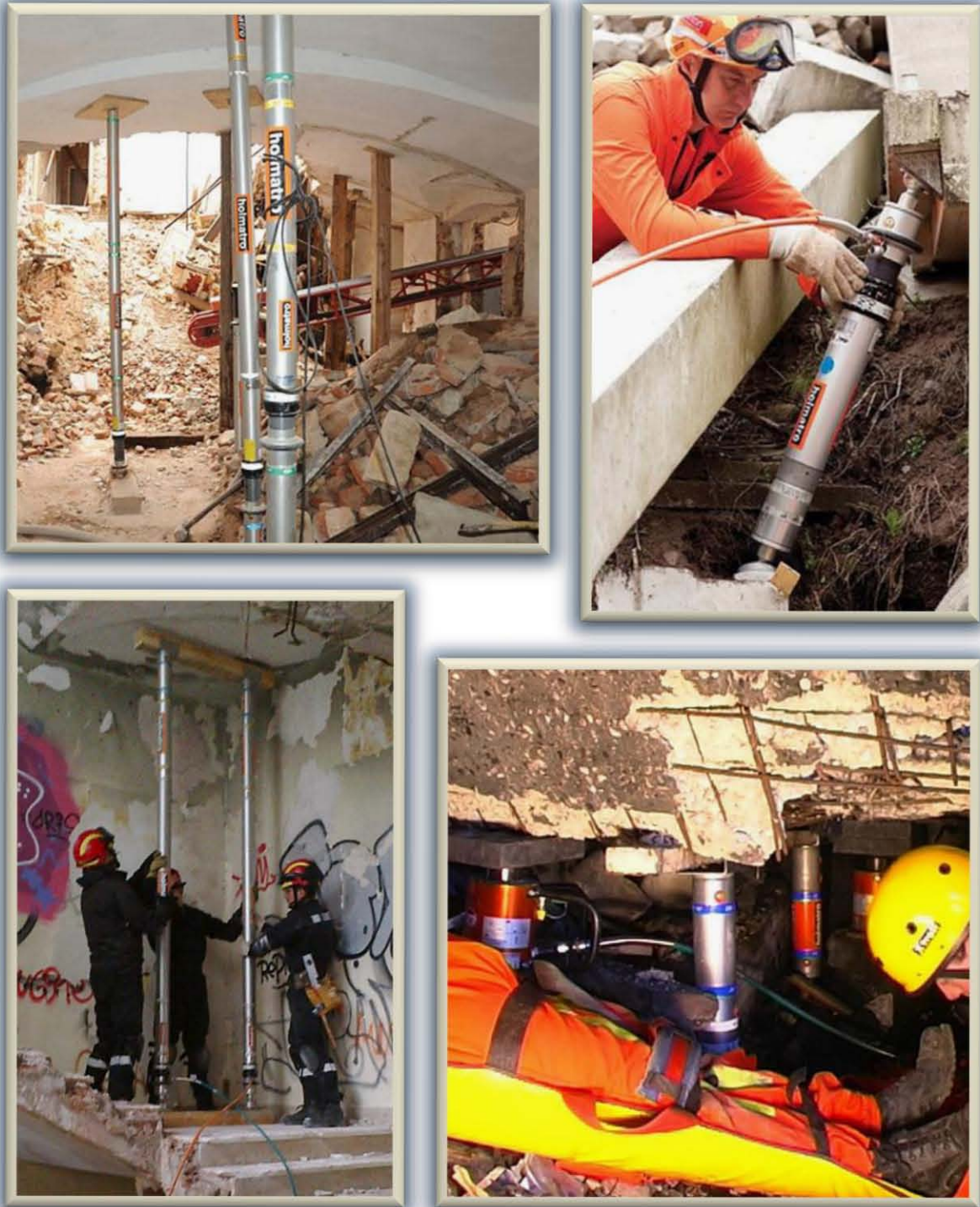
Fig. 2.1.2.25 Imágenes de usos de puntales neumáticos e hidráulicos. Arriba izq., soportes neumáticos apuntalando edificio parcialmente colapsado. Abajo izq., puntales hidráulicos para soporte de losa en descanso de escalera. Arriba y abajo der., soportes hidráulicos de corta longitud con capacidad de elevación remota, utilizados sobre todo para operaciones de rescate en espacios reducidos
