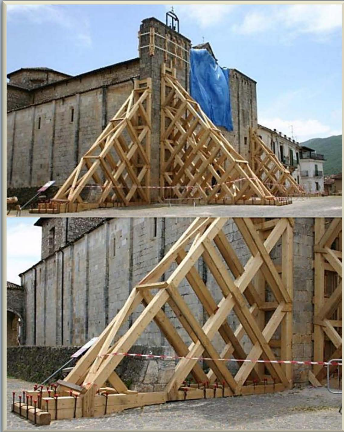
Fig. 2.1.3.4. Apuntalamientos de triángulo completo de fachada de mampostería, constituidos por 2 hileras de 3 puntales inclinados paralelos, con riostras de apoyo y cruzadas. Abajo, acercamiento para apreciar el anclaje de la base
