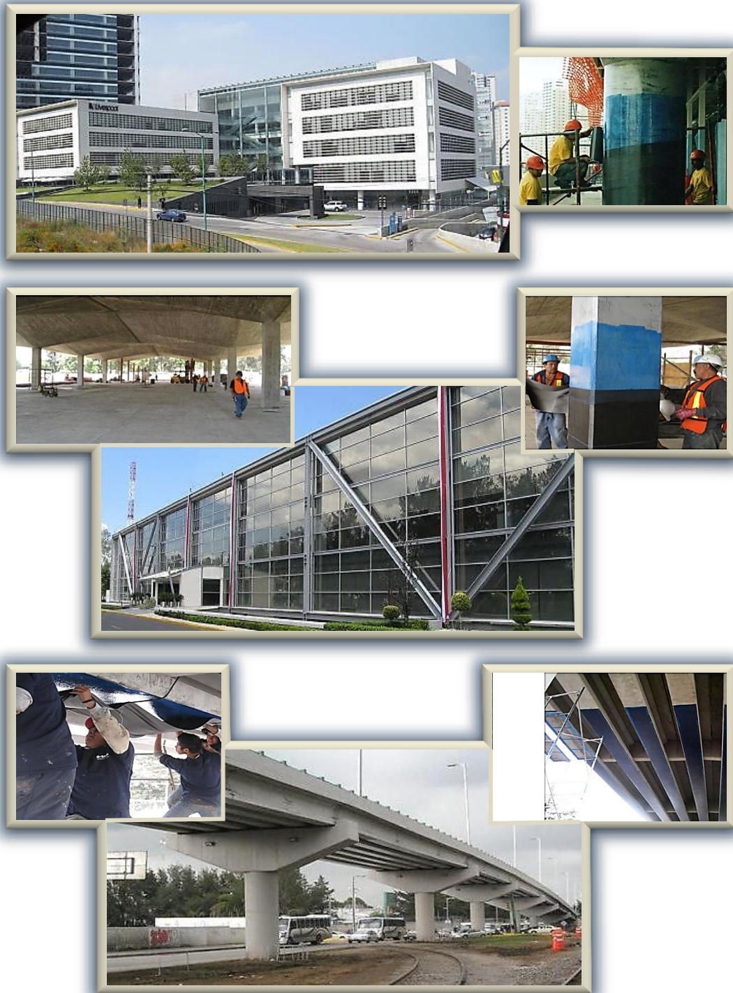
Fig. 3.3.5. Uso de fibras de carbono para reforzamiento de estructuras diversas. Arriba, refuerzo de columnas con malla BRACE FC130 en edificio de oficinas, Santa Fe, Cd. de México. En medio, misma malla para refuerzo de columnas de edificio de capacitación de ASA, aeropuerto internacional de la Cd. de México. Abajo, aplicación de dicho sistema para el reforzamiento de traveses del puente Tollocan, Toluca, Estado de México
