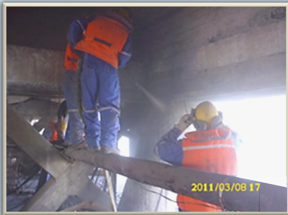
Fig. 2.2.3.4. Aplicación de concreto lanzado para reforzamiento de un nodo de una estructura marítima, no obstante la dificultad que origina su ubicación y geometría
