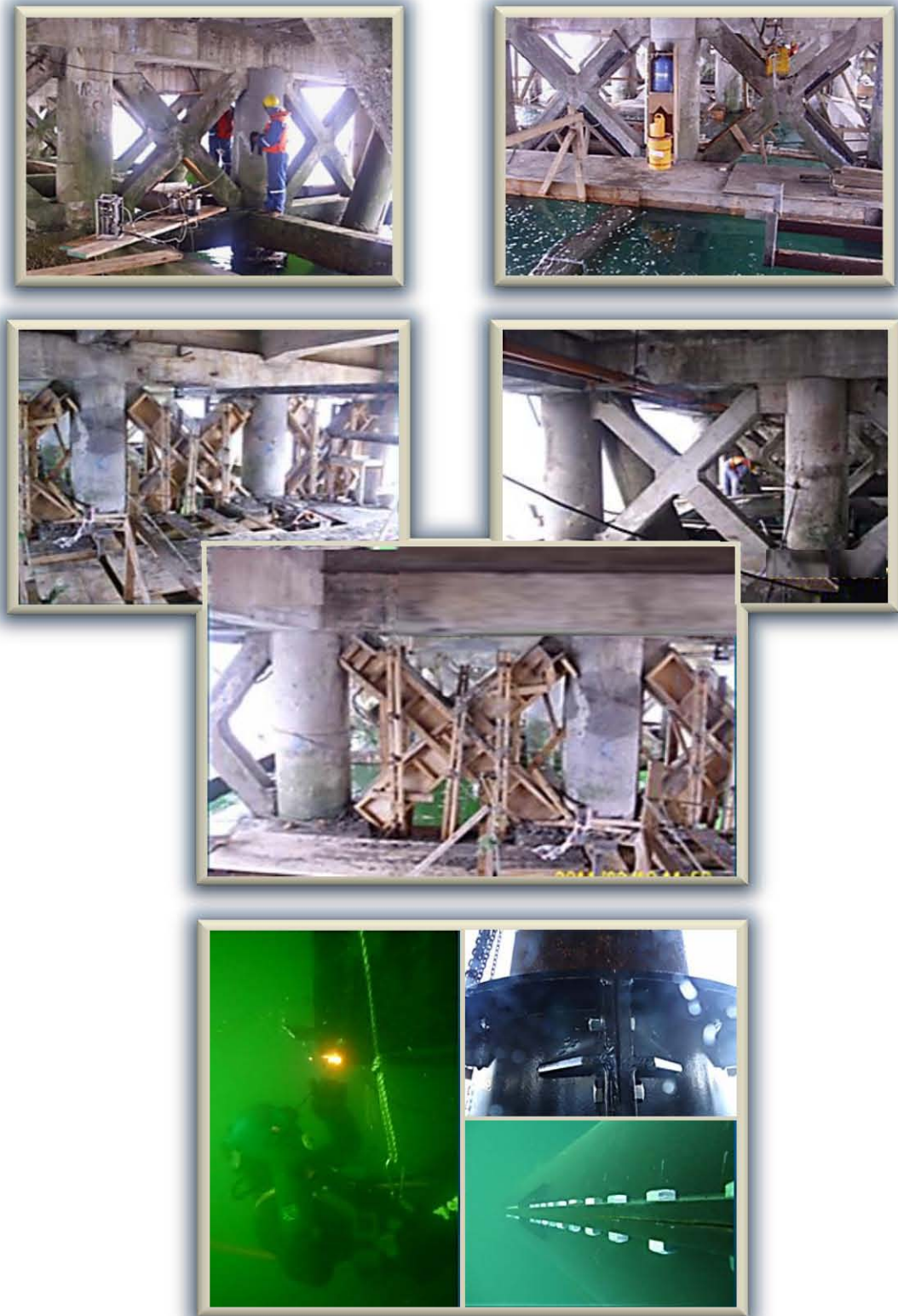
Fig. 3.3.2. Aplicación de distintos métodos de restauración en el muelle. Arriba, inyección de resinas y morteros epóxicos. En medio, reposición parcial y/o total de crucetas de concreto. Abajo, encamisados de acero en pilotes (parte sumergida)
