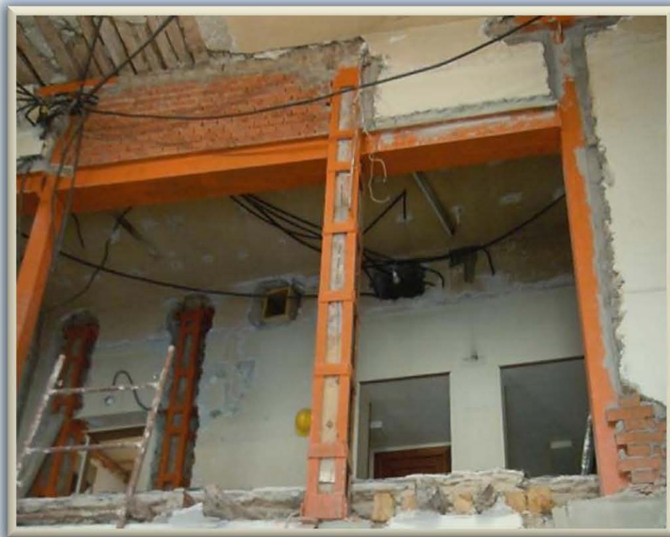
Fig. 2.1.2.14 Edificio antiguo de mampostería apuntalado con perfiles metálicos que fueron aprovechados para incorporarlos a la estructura, tanto en sustitución de columnas completas, como en reforzamiento de otras mediante la técnica de encamisado
