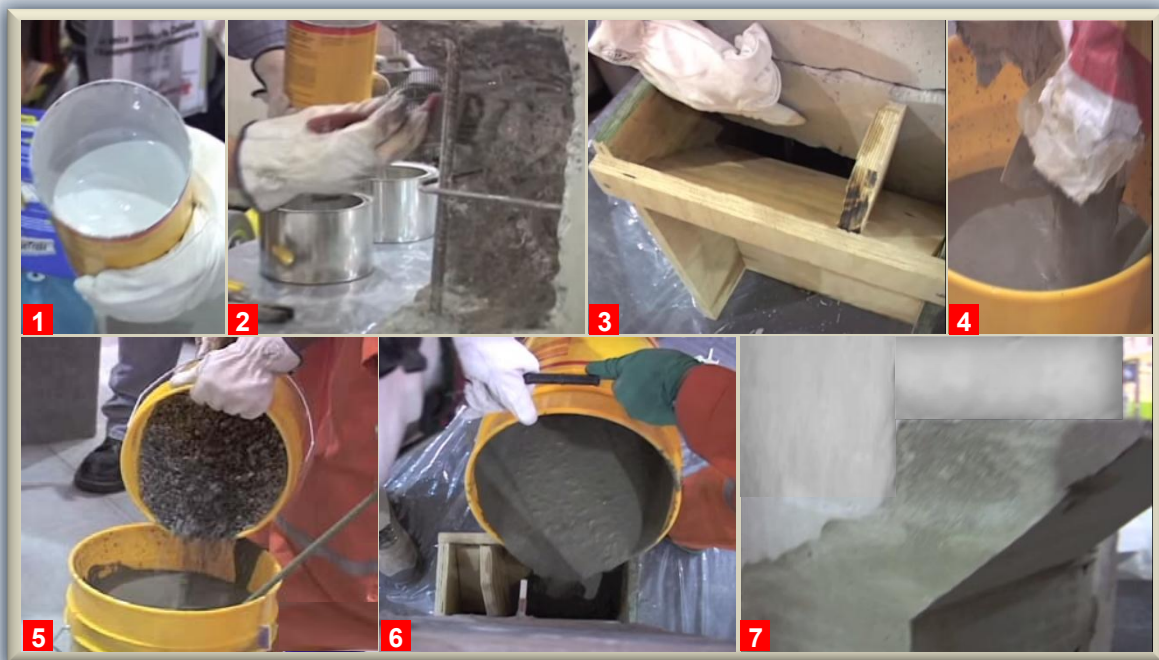
Fig. 2.2.3.4. Secuencia de preparación y aplicación de concreto con resina para reconstrucción de un elemento estructural
