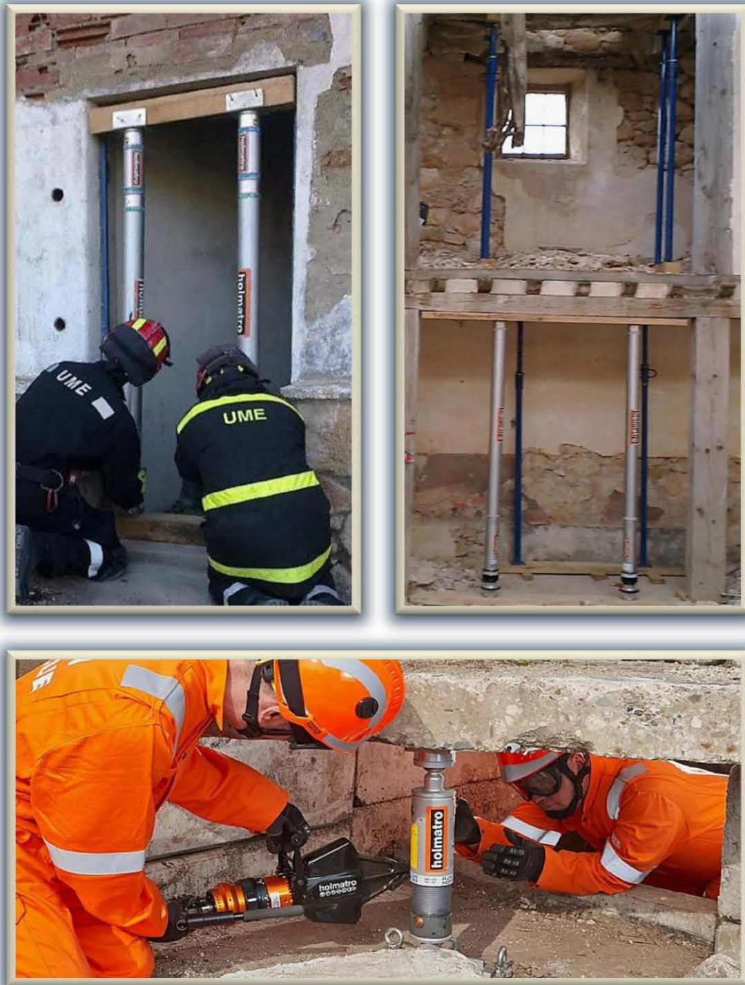
Fig. 2.1.2.24 Usos de puntales mecánicos modernos. Arriba izq., apuntalamiento de vano de puerta de edificio antiguo. Arriba der., empleo combinado con puntales tubulares convencionales. Abajo, puntal de corta longitud utilizado para elevación de losa de concreto
