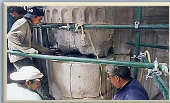
Fig. II.19. Sustitución de sillares en la columna C-6
