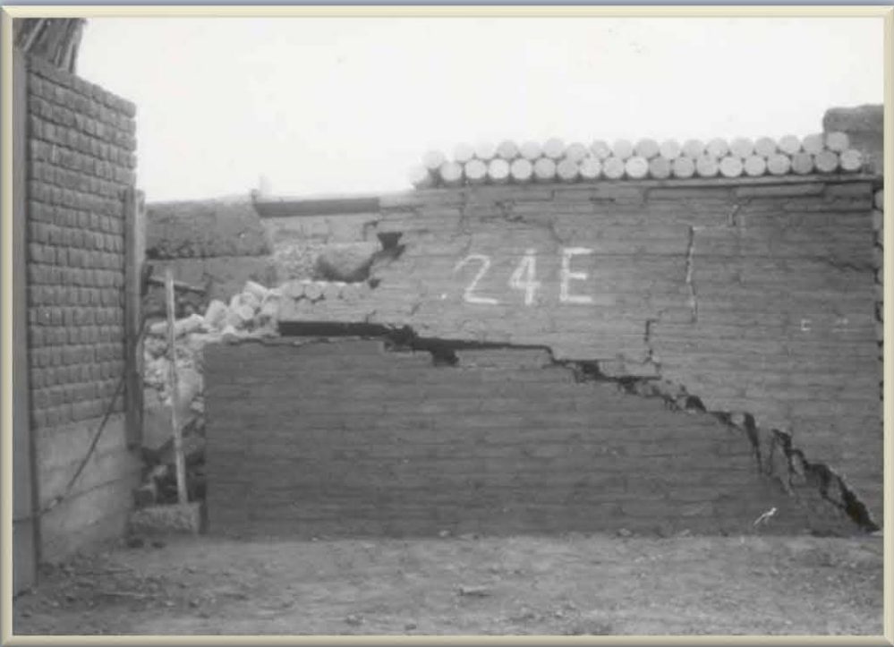
Fig. 1.2.1.f.2-2.3) Ejemplificaciones de fallas por flexión vertical perpendicular a los planos de muros, tal como lo indican los esquemas de la página anterior
