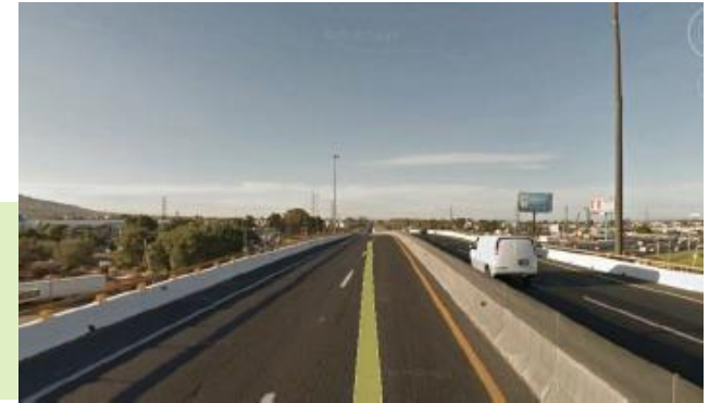
Carriles de Circuito Exterior Mexiquense
