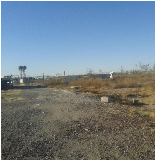
Fotografía de la subestación en el terreno
