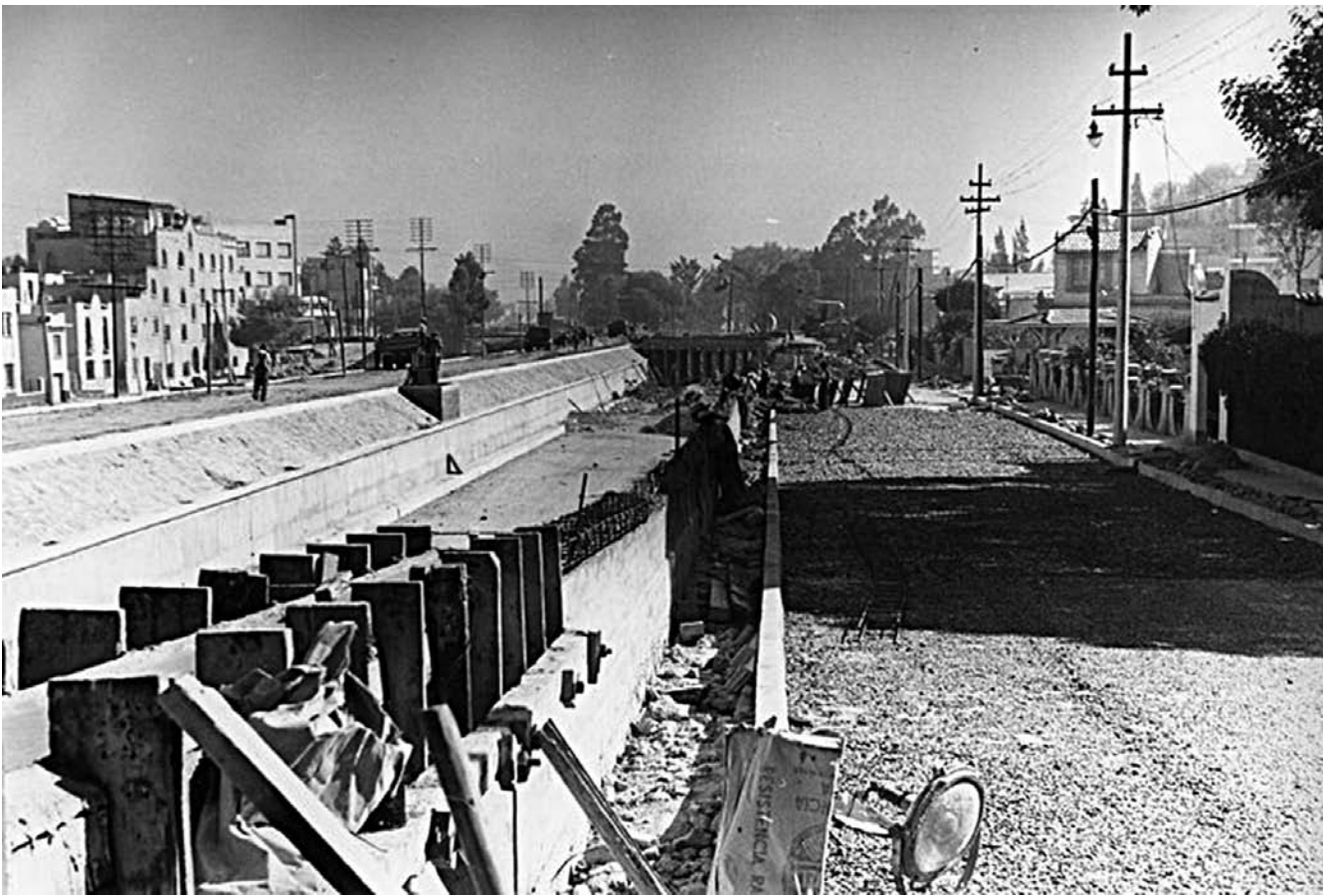
1952. Construcción del Viaducto. Del lado derecho se observa la Colonia del Valle. Imagen tomada de La Ciudad de México en el Tiempo .
