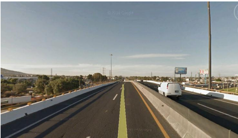
(Circuito Exterior Mexiquense)
