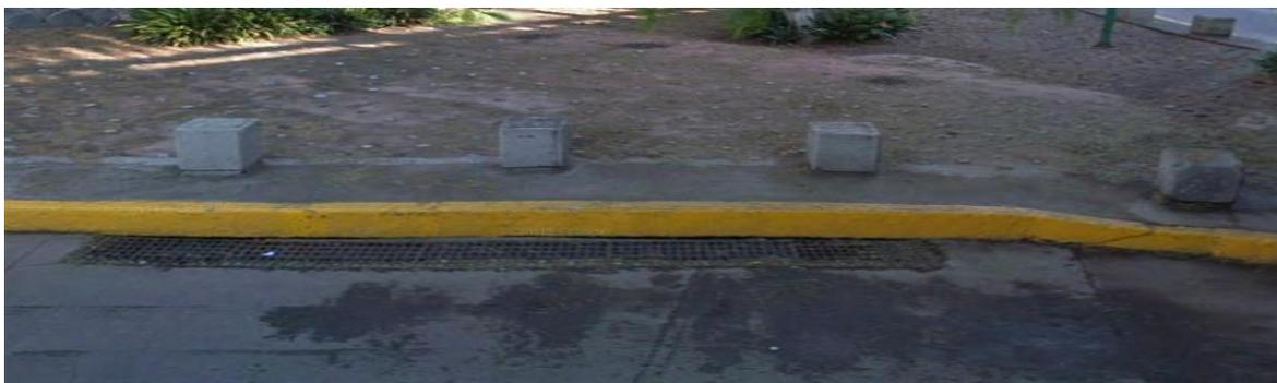
**Figura 5.3** Rejilla por donde entra el agua pluvial al pozo de Rectoría.
