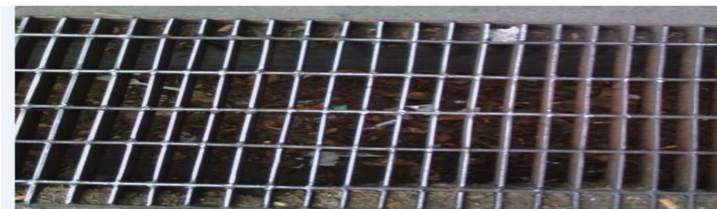
**Figura 5.4. Rejilla por donde entra el agua pluvial al pozo de Medicina**
