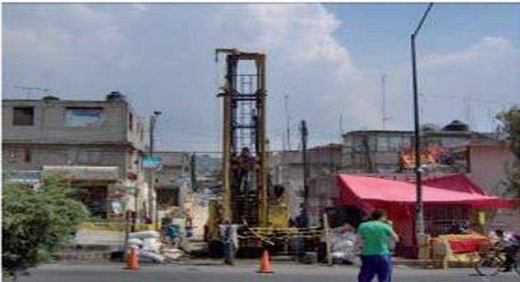
**Figura 1.2 Pozo de absorción en Iztapalapa**
