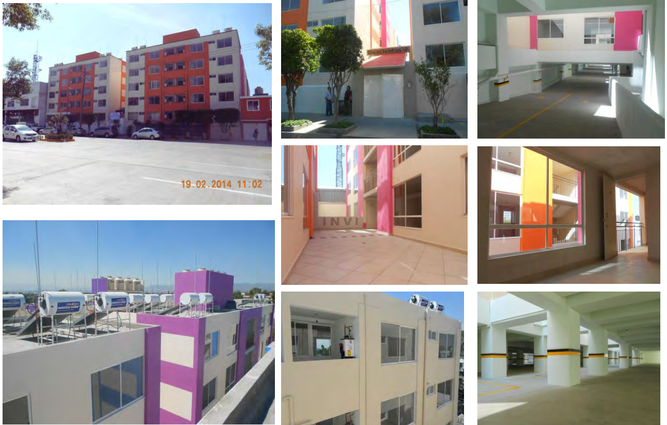
Al término de la construcción: Vistas generales de los conjunto habitacional. Se observa los calentadores solares, calentadores de paso, pasillos peatonales, estacionamiento y el interior de las viviendas.
