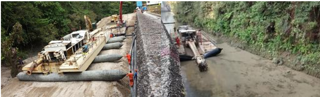
Figura 27. Botado de la draga al embalse.
