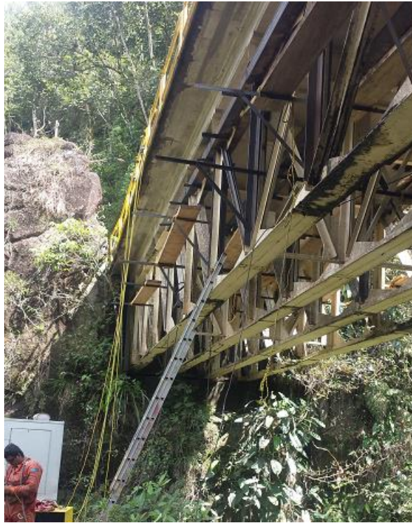
Figura 24. Reforzamiento del puente la Soledad.
