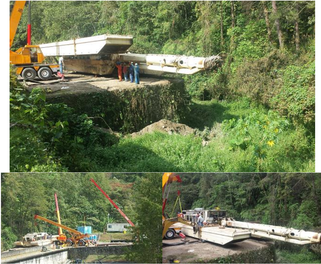
Figura 26. Armado de los componentes de la draga.
