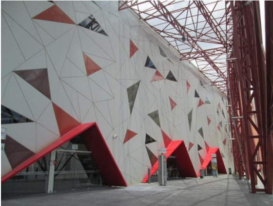
I.28 Pórtico de Acceso
