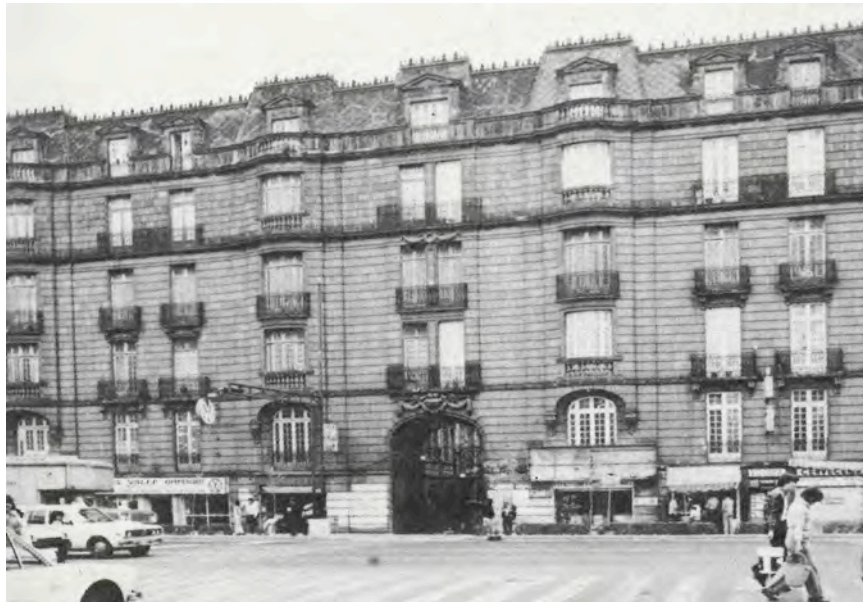
Fuente: Fachada principal del conjunto El Vizcaya, "Catálogo de la Exposición de Arquitectura en México. Porfiriato y Movimiento Moderno", I.N.B.A., 1983.
