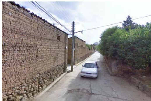
Calle con dos casas tradicionales en buen estado.
