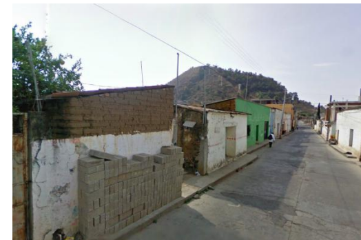
Sustitución del adobe por el block de concreto.
