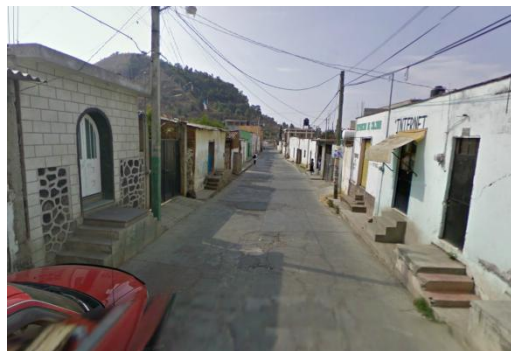
Casas en calle con pendiente con escaleras para acceso.
