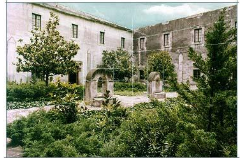
•Arriba. Chultun, en la región Puuc Maya; Patio de los aljibes, ex convento jesuita de Tepozotlan
