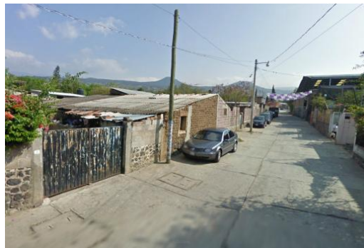
Casas de un nivel. Cubiertas tradicionales sustituidas por lámina de asbesto y galvanizadas.
