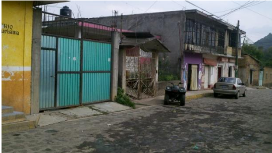
VISTAS: CALLE E. ZAPATA
