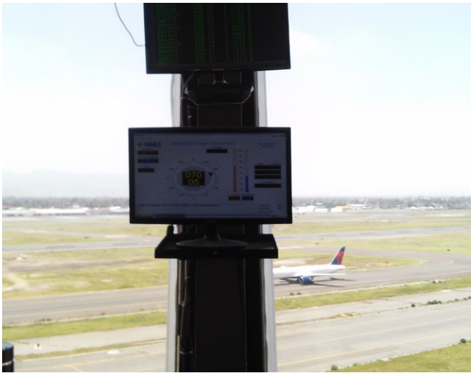
Figura 20: Columnas como obstáculo visual.
