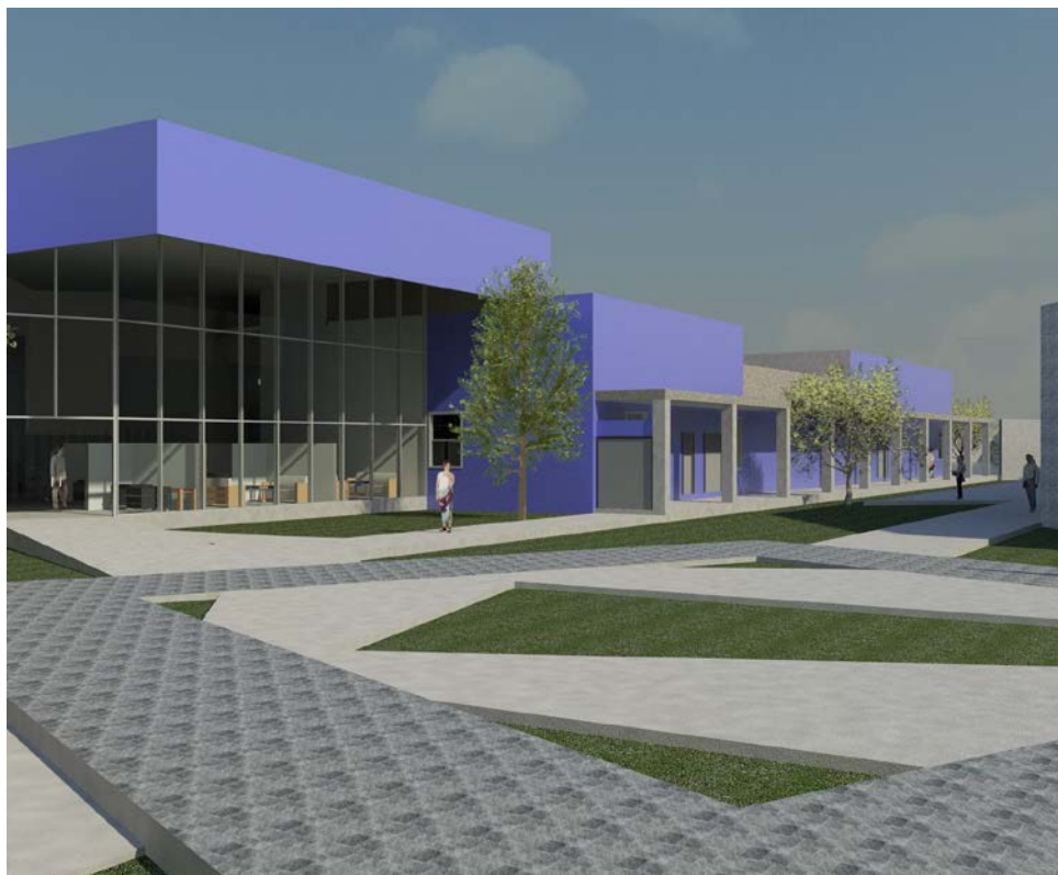
Perspectiva del edificio principal del lado posterior (Sureste).
