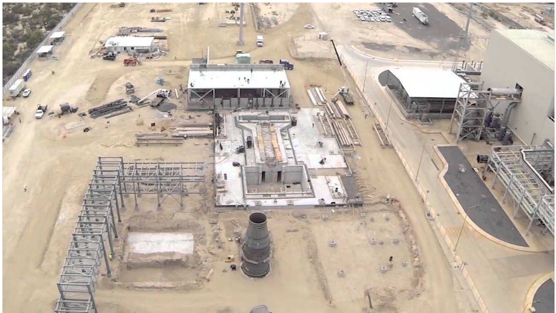
Figura 3.4. Casa de Máquinas, construcción de la cimentación
