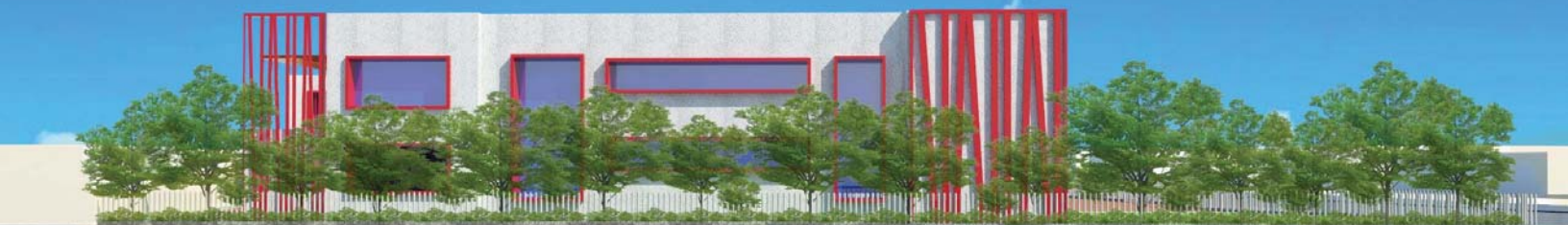
FACHADA OESTE – COLINDANCIA
