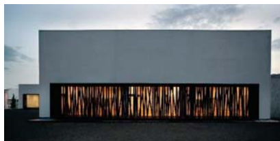
FACHADA POSTERIOR DE LA ESCUELA
