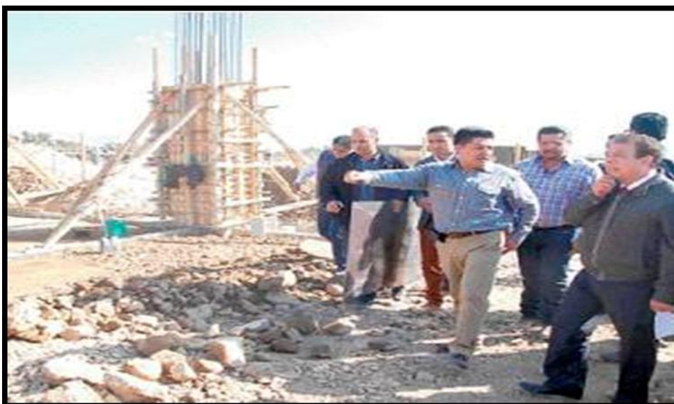
Figura 3.6 Joel Guerrero, titular de la SEPH en Hidalgo, supervisó los avances de obra de la Ciudad del Conocimiento, en la comunidad Santiago Tlapacoya (El Sol de Hidalgo, 2013)
