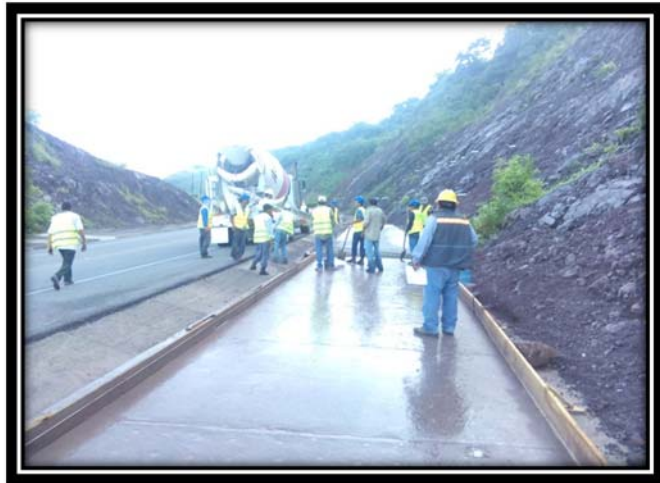
Fig. 33 Talud km 197+500 (vista durante de los trabajos)
