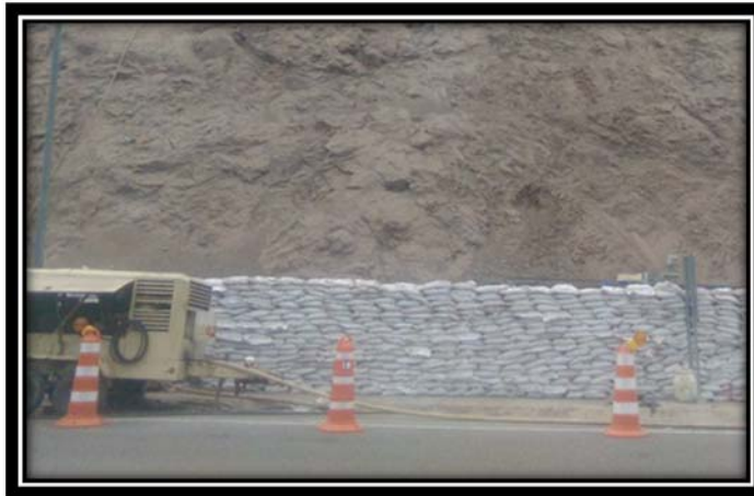
Fig. 11 Talud km 163+950 al 164+100 (barrera de protección km 164+000)
