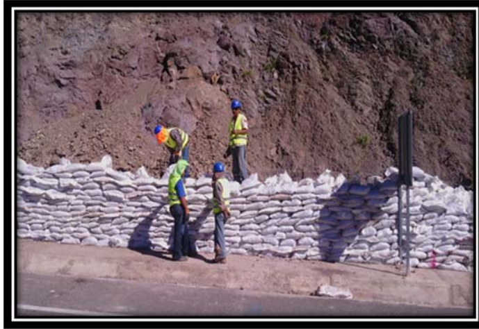
Fig. 10 Talud km 163+950 al 164+100 (Colocación de barrera de protección km 164+000)
