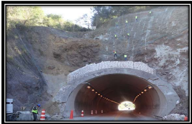
Fig. 30 Talud km 195+550 (vista durante de los trabajos)
