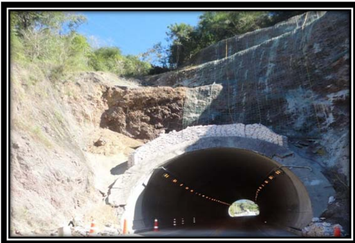
Fig. 31 Talud km 195+550 (vista después de los trabajos)
