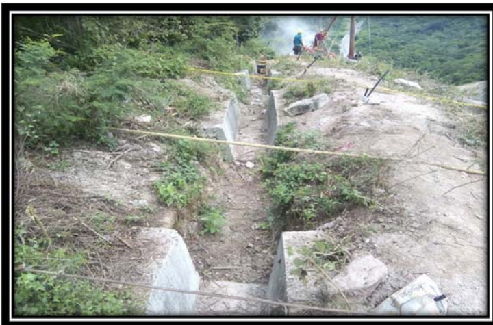
Fig. 38 Talud km 207+120 al 207+180 (vista antes de los trabajos)
