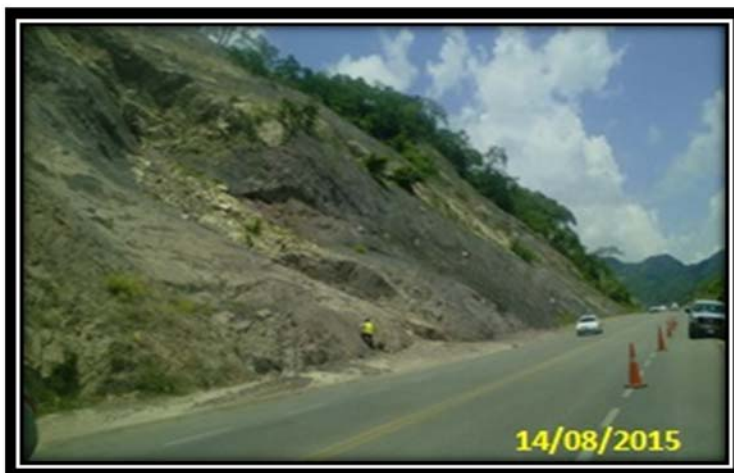
Fig. 12 Talud km 197+500 al 197+950 (amacice de taludes km 197+850)
