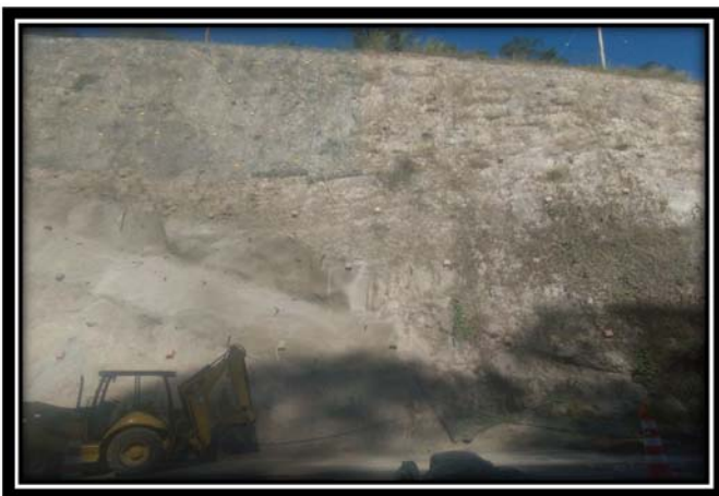
Fig. 22 Talud km 207+120 al 207+180 (vista después de los trabajos)
