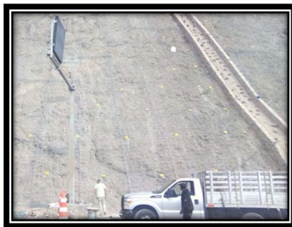
Fig. 21 Talud km 163+950 al 164+100 (vista después de los trabajos)
