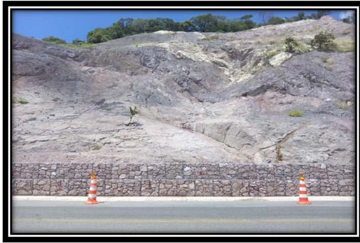
Fig. 14 Talud km 197+500 al 197+950. (vista final de los trabajos)
