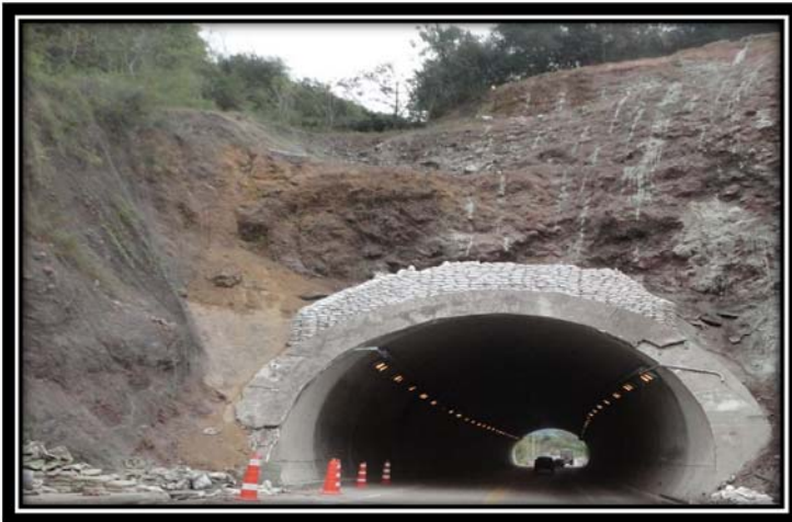
Fig. 29 Talud km 195+550 (vista antes de los trabajos)
