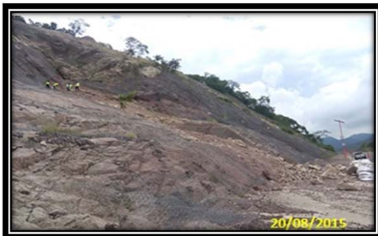
Fig. 13 Talud km 197+500 al 197+950 (trabajos de amacice)
