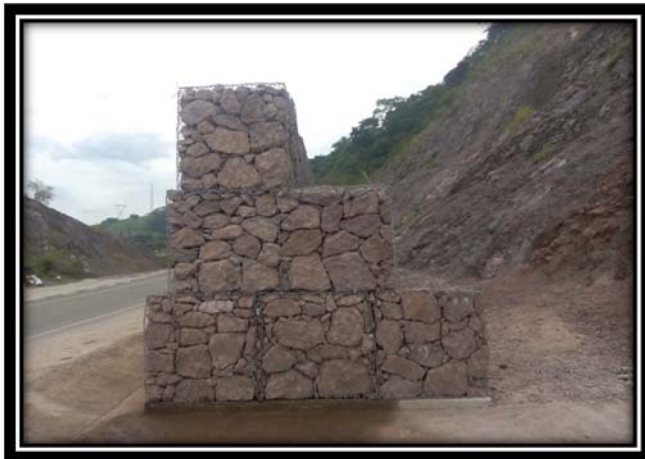
Fig. 34 Talud km 197+500 (vista después de los trabajos) EP- 05 Construcción de contracunetas (murete de mampostería)
