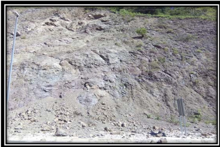
Fig.9. Talud km 163+950 al 164+100
