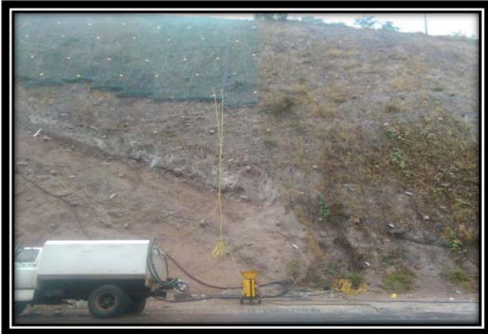
Fig. 25 Talud km 207+120 al 207+180 (vista antes de los trabajos)
