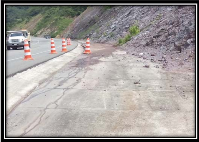
Fig. 32 Talud km 197+500 (vista antes de los trabajos)
