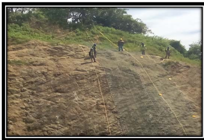
Fig. 17 Talud km 201+100 al 201+200 (vista durante de los trabajos)
