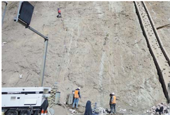
Fig. 20 Talud km 163+950 al 164+100 (vista durante de los trabajos)
