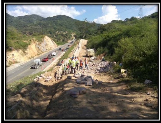
Fig. 36 Talud km 196+100 al 196+400 (vista durante de los trabajos)
