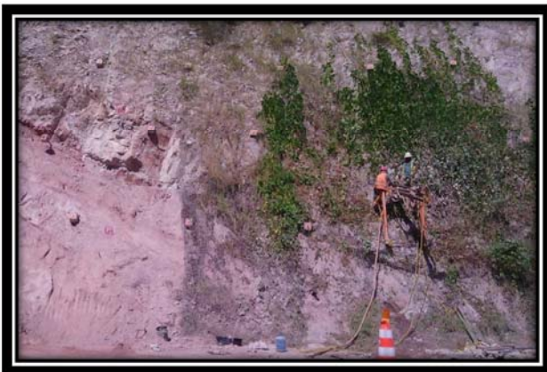
Fig. 23 Talud km 207+120 al 207+180 (vista durante de los trabajos)
