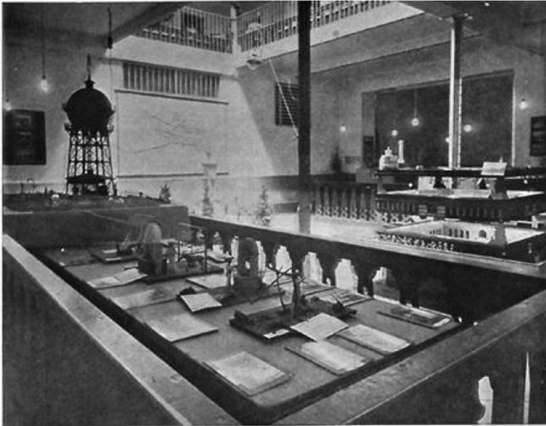
SISTEMAS DE APROVISIONAMIENTO DE AGUAS POTABLES EN LA EXPOSICION DE HIGIENE.
