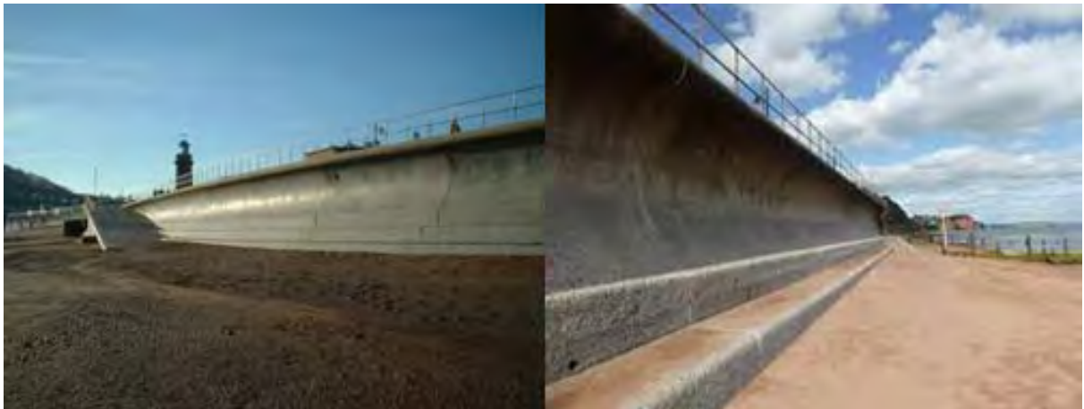
Figura 1. 10 Muro con cara frontal curva
