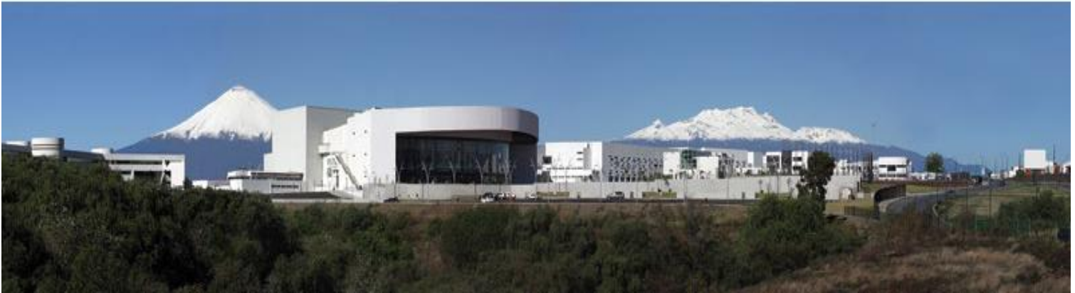
Vista panorámica del Complejo Cultural
