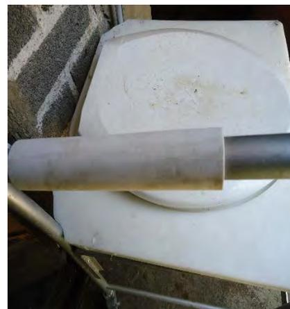
Figura 84. Suciedad en recubrimiento de Foami.
