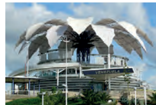
IMAGEN 1. Pabellón de Venezuela en la Exposición Universal de Hannover 2000, en su ubicación actual en el país de origen. Fuente: www.aporra.org
