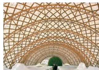
IMAGEN 2. Interior del pabellón de Japón en la Exposición Universal de Hannover 2000. Fuente: Alquialter Arquitectura Alternativa
