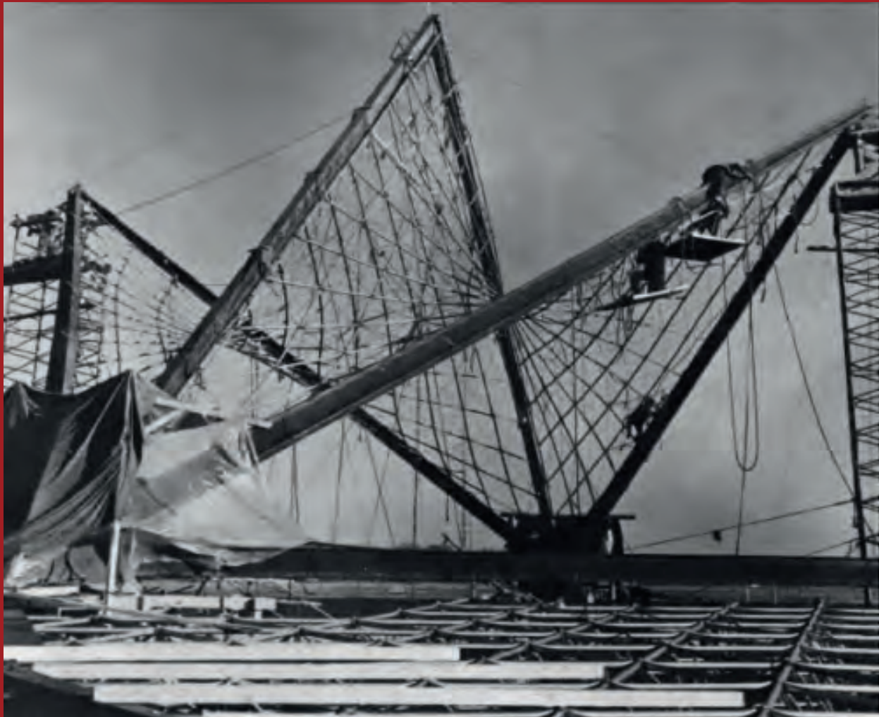
IMAGEN 71. Estructura para el Pabellón de México en la Exposición Universal de Montreal 1967. Fuente: Tumblr.com usuario: unavidamoderna
