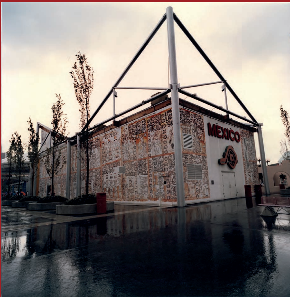
IMAGEN 94. Pabellón de México en la Exposición Especializada de Vancouver 1986. Fuente: Arq. Ernesto Velasco León.
