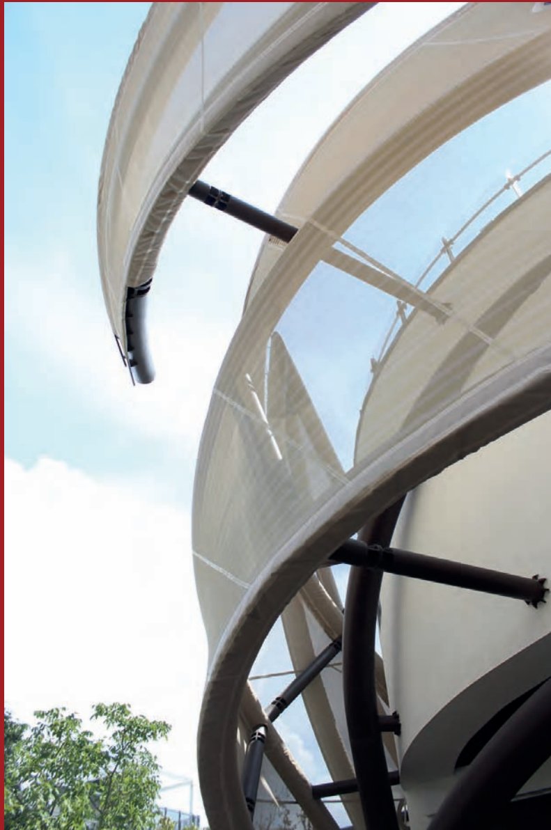
IMAGEN 53. Pabellón de México en la Exposición Universal de Milano 2015. Estructura de doble fachada Fuente: Autor.
