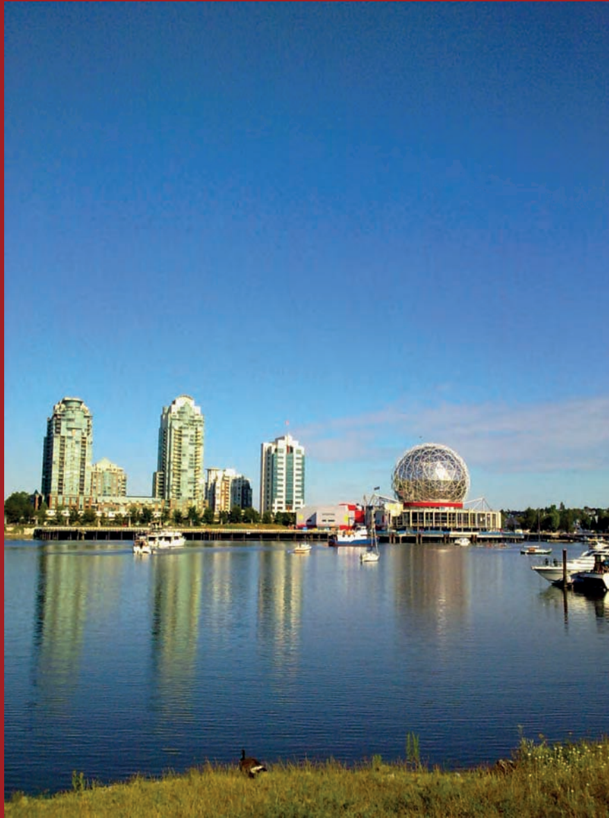
IMAGEN 93. Expo Center (izquierda), edificio ícono de la Exposición Vancouver 1968. Edificio activo, hoy en día es museo de ciencias, TELUS World of Science. Fuente: autor, 2011.
