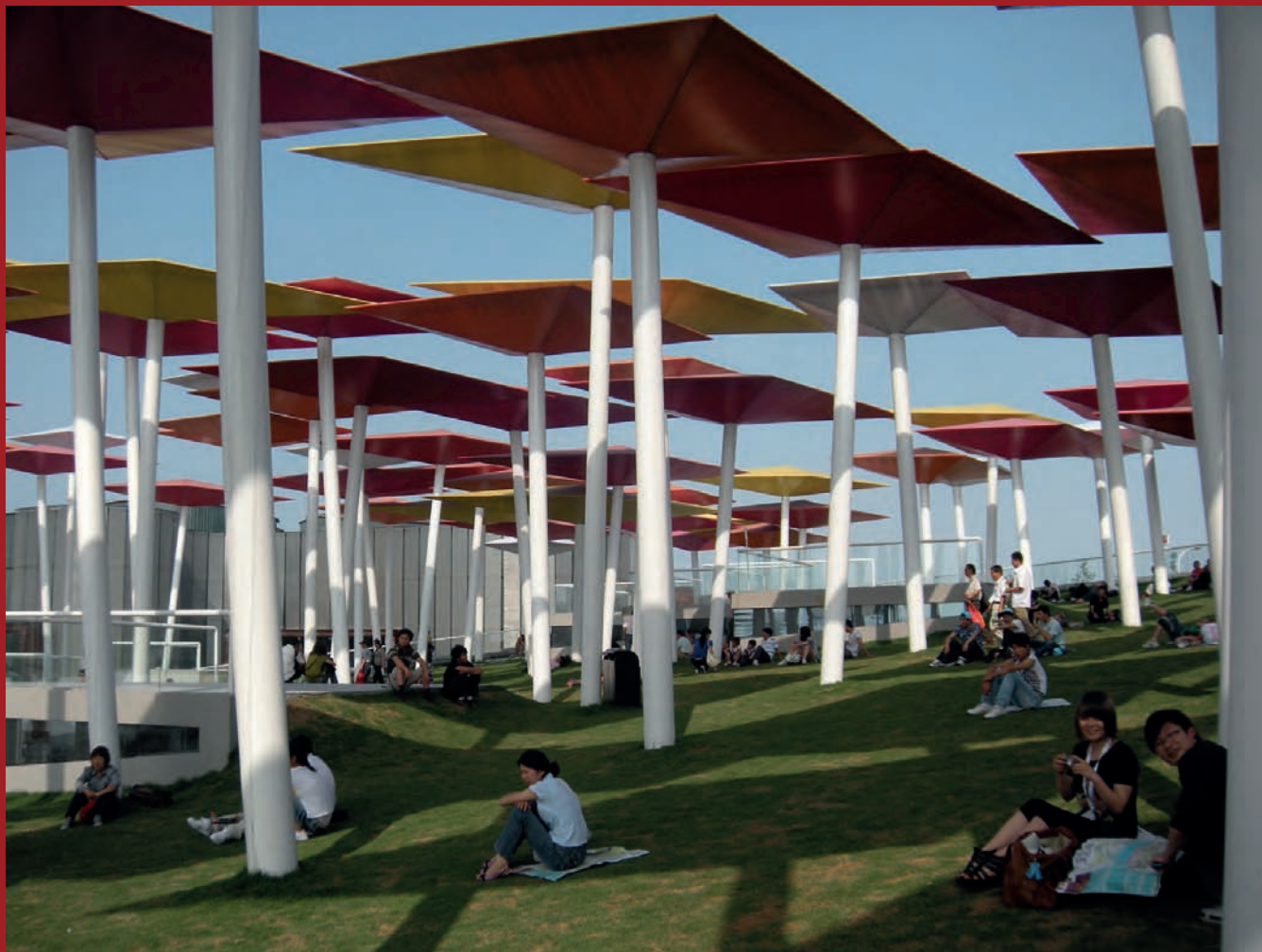
IMAGEN 31. Pabellón de México en la Exposición Universal de Shanghai 2010. Cubierta practicable. Fuente: Flickr.com usuario Kristina Washington ©.
