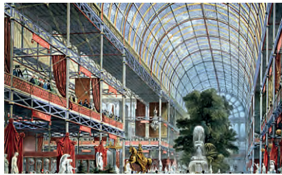
IMAGEN 3. Interior del Pabellón conserva los árboles existentes
