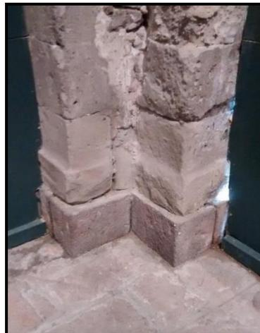
Figura 3.4 Desgaste en basa de columna
