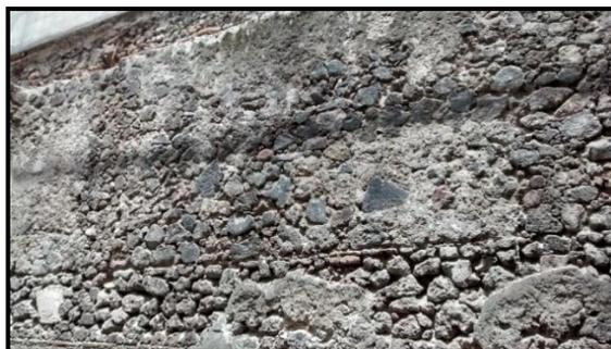
*Figura 4.1 Muro fabricado con mampostería de tezontle*
