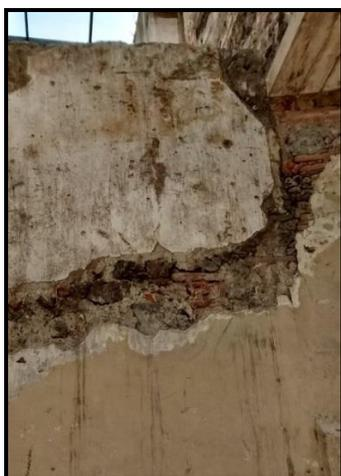
Figura 3.5. Muro con falla por cortante
