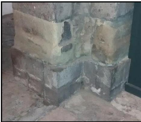
Figura 3.18 Basamento existente en columna de esquina Sur-Poniente.
