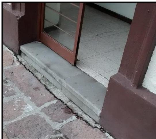
*Imagen 6.46 Separación de crujía sur con Pasillo en 1er Nivel.*
