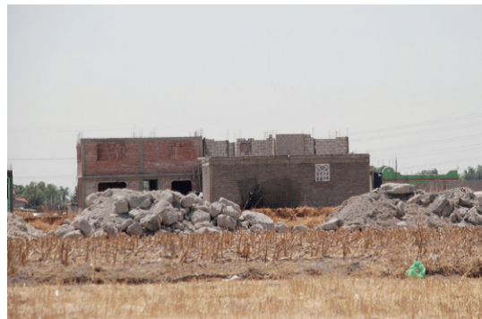
Construcción de viviendas en terrenos agrícolas
