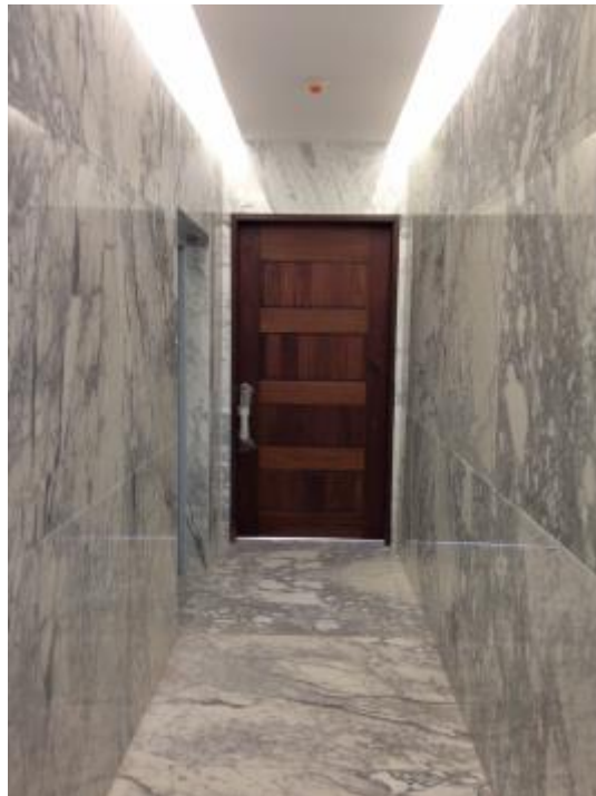
Ilustración 47. Acabado de mármol en pasillos de entrada a departamentos
