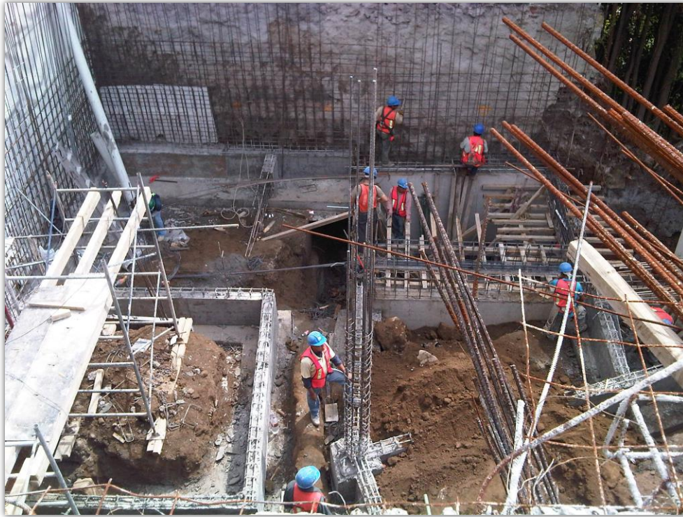
Ilustración 32. Trabajos de albañilería en cimentación
