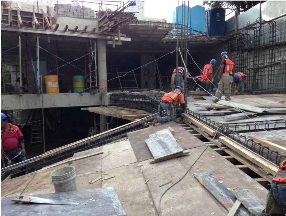
Ilustración 34. Trabajos de albañilería en rampa
