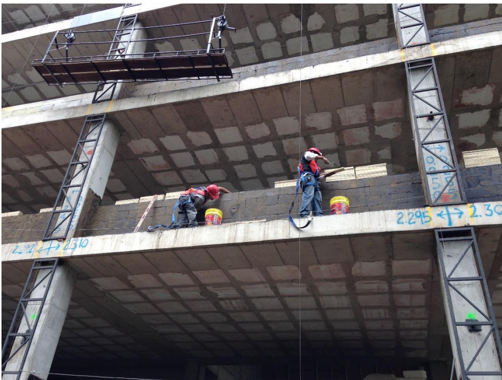
Ilustración 35. Impermeabilización de muretes para la colocación de acabados
