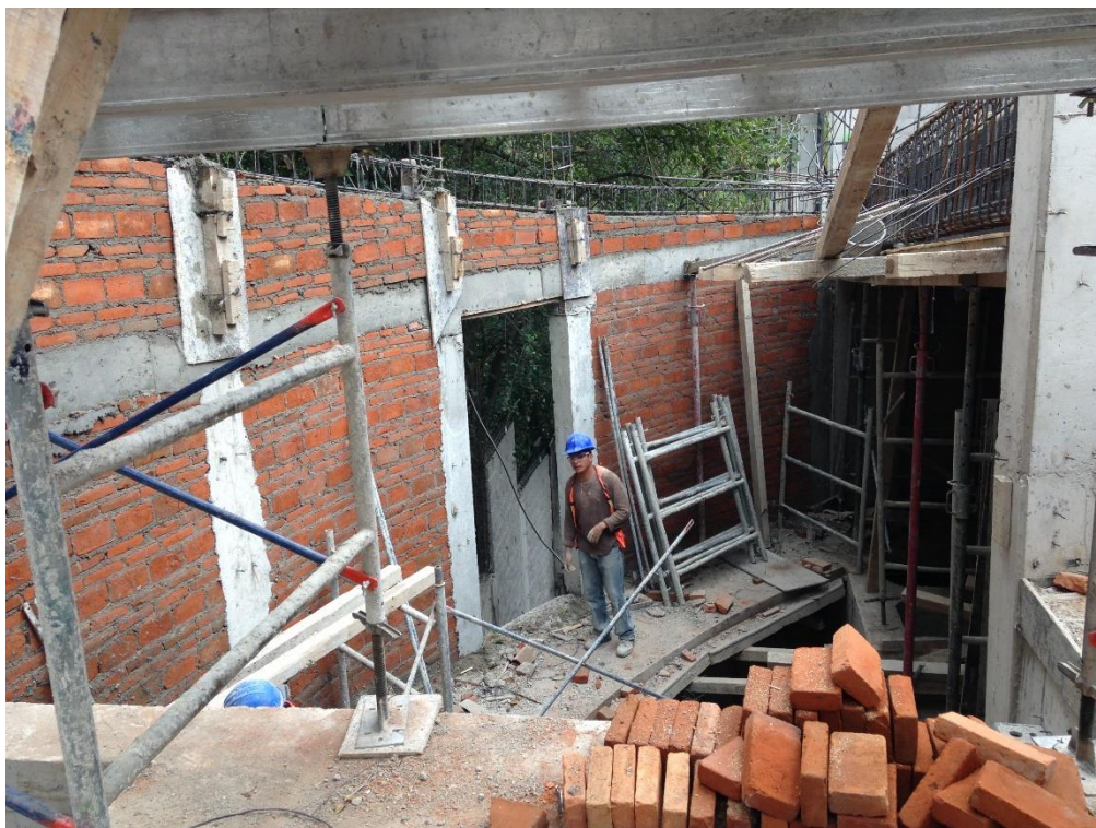
Ilustración 33. Trabajos de mampostería en rampa de Estacionamiento
