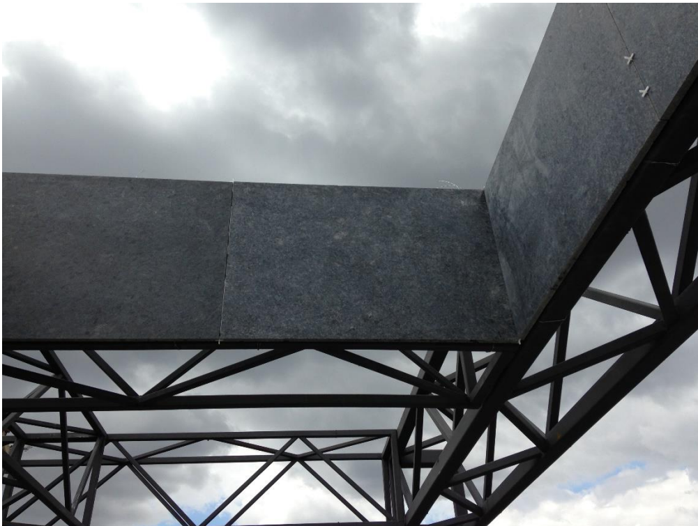
Ilustración 39. Estructura metálica de celosía para colocación de granito Caledonia
