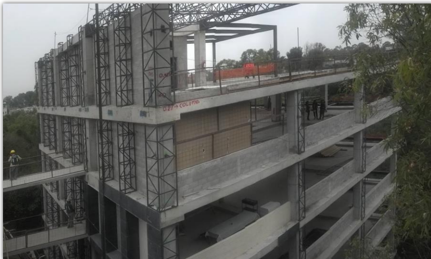
Ilustración 37. Estructura metálica de soporte para granito Caledonia en columnas
