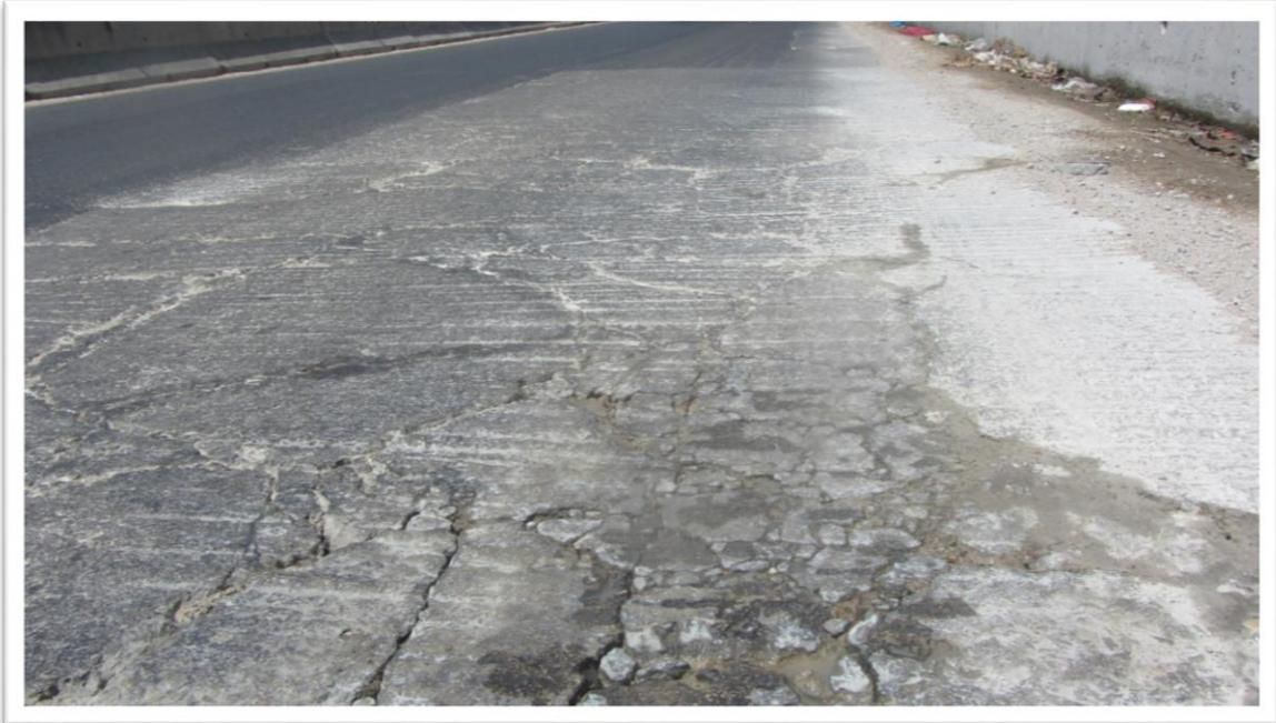
*Fotografía 3.1.2.3.- Agrietamiento severo, km 3+820 cuerpo B.*
