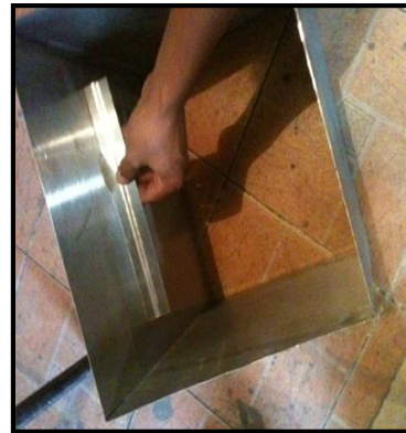
Figura 23. Fabricación de los rieles para la colocación de rejillas.
