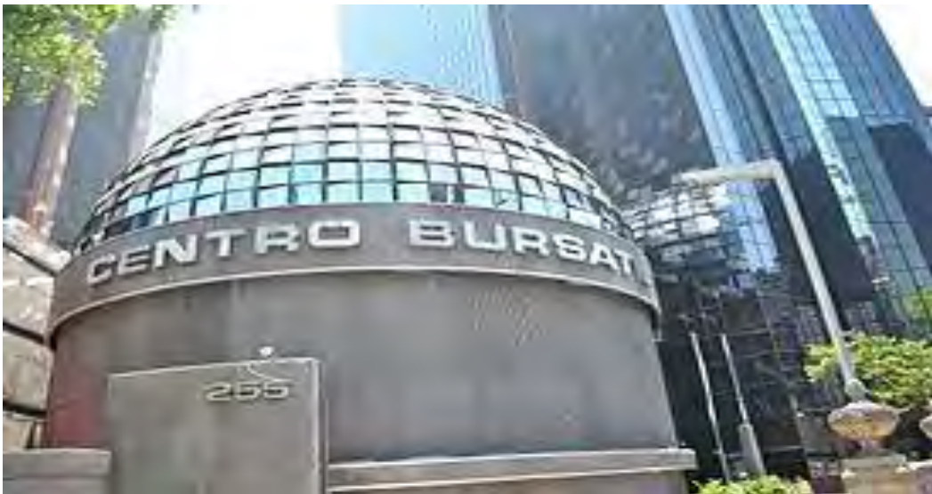
Centro bursátil en Paseo de la Reforma.
