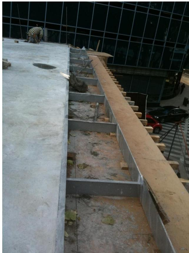
**FIG. DD** (en la foto se muestra como queda integrada la estructura metálica y su cimbrado para la segunda fachada de cristal).
