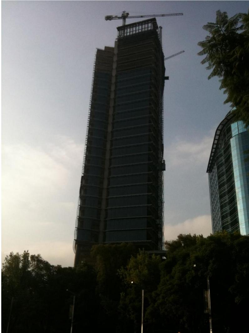
**FIG. TT** (imagen donde se observa el elevador exterior para el personal).
