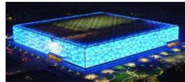
Iluminación nocturna de la fachada del cubo de agua
