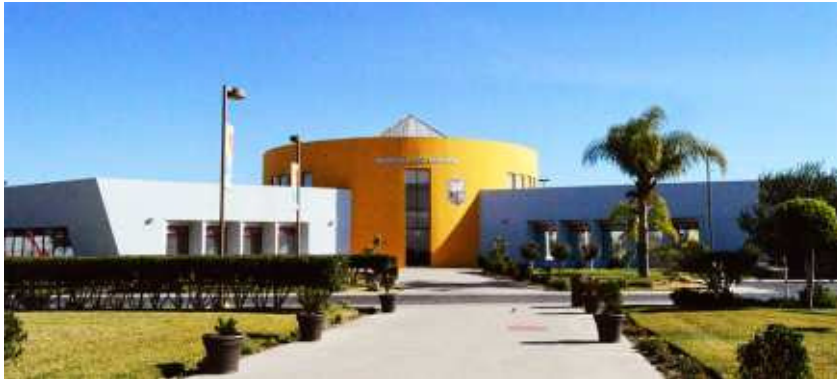
Fachada del edificio de medicina del deporte.
