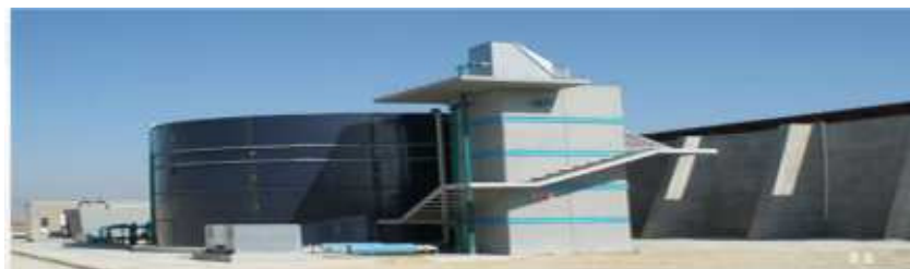
Fachada de la planta de tratamiento.
