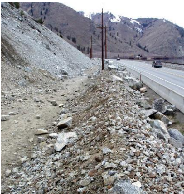
Figura 7.4.1. Áreas de captación hechas de tierra estabilizada mecánicamente. Izquierda: berma a la orilla de una carretera. Tomada de Richard (et. al., 2011, p. 90)
