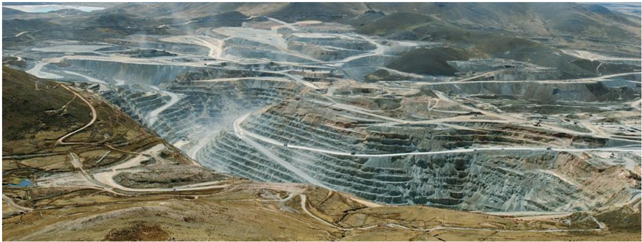
Fig. 2.2 Excavación a cielo abierto. Taludes diseñados para una mina en Argentina. Recuperado de: http://www.srk.com.ar/es/open-pit
