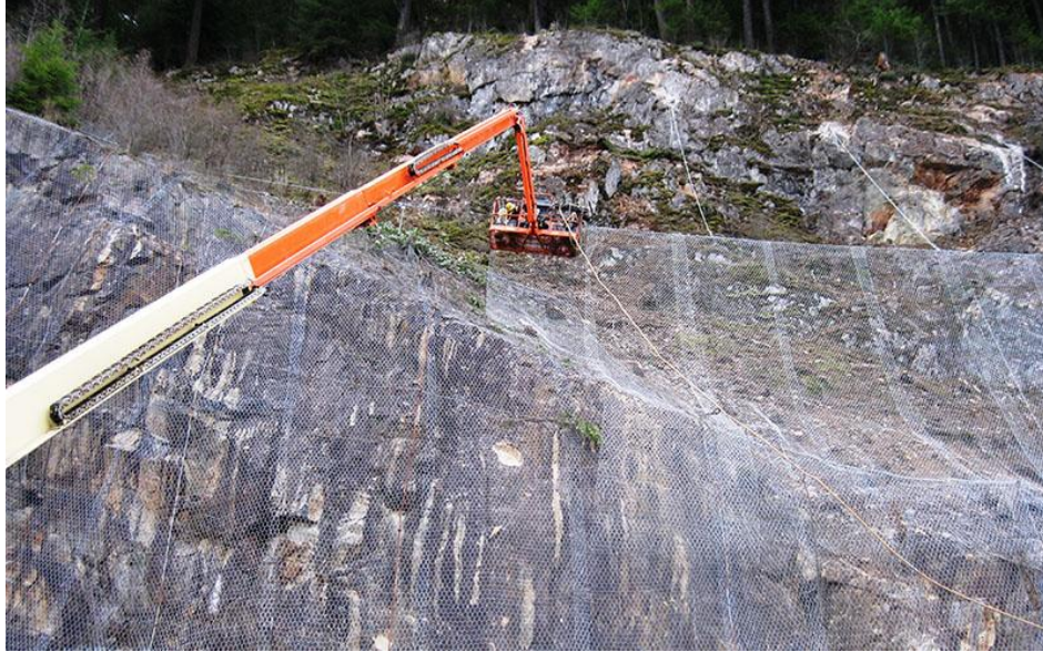
Figura 6.5.1. Instalación de una draped mesh . Recuperado de: http://www.blastingconsultants.com/gallery/
