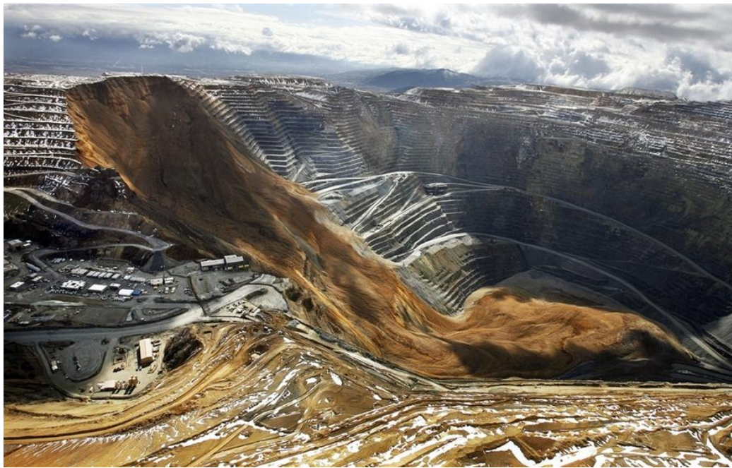
Fig. 2.7 Deslizamiento ocurrido en la mina de cobre Bingham Canyon ubicada 20 [km] al suroeste de Salt Lake City, USA. Las intensas lluvias disminuyeron la resistencia permitida del material llevándolo a fallar. Recuperado de: http://enriquemontalar.com/el-impresionante-deslizamiento-de-tierras-de-la-mina-de-cobre-de-bingham-canyon/
