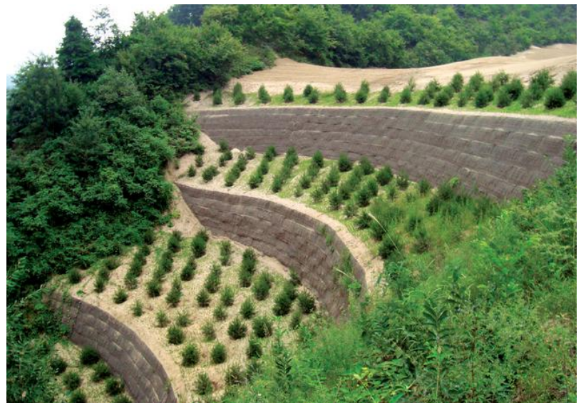
Figura 7.4.1. Áreas de captación hechas de tierra estabilizada mecánicamente. Izquierda: berma a la orilla de una carretera. Tomada de Richard (et. al., 2011, p. 90)
