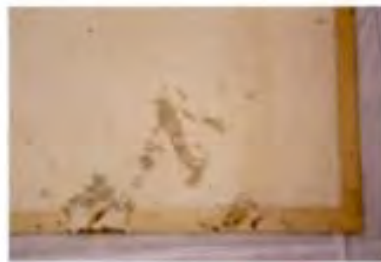
Manchas de pintura y recubrimiento adhesivo
