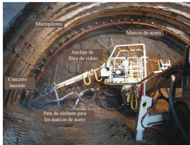
Figura 2.2. Frente con un sistema combinado de sostenimientos, tomada de (Hoek, 2001)
