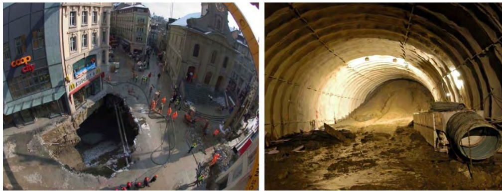
Figura 3.4. Colapso del metro de Lausanne, Suiza (2005).
