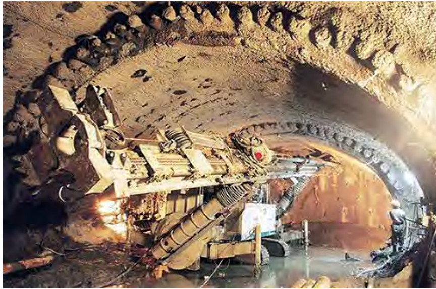
Figura 2.1. Colocación del paraguas de micropilotes
