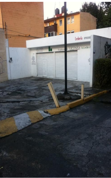
Vista 7 -Lechería Liconsa Existente
