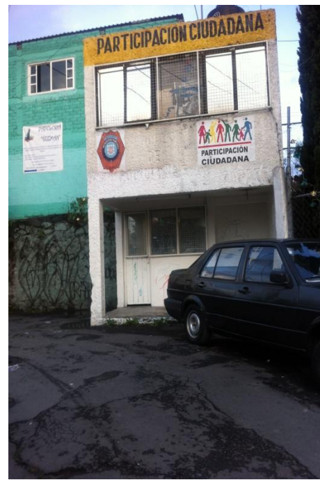
Vista 9- Modulo de Vigilancia.
