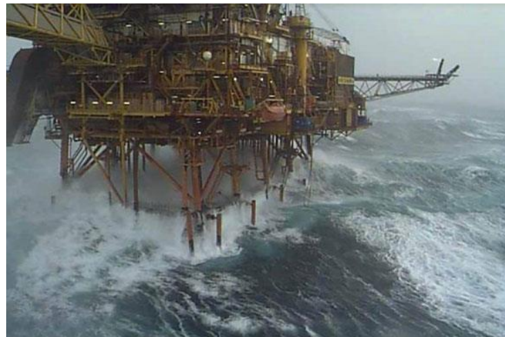
Figura 3. Ejemplo de una plataforma fija sometida a las acciones debidas a tormenta (Oil Industry News, www.oilandgaspeople.com, 2015)
