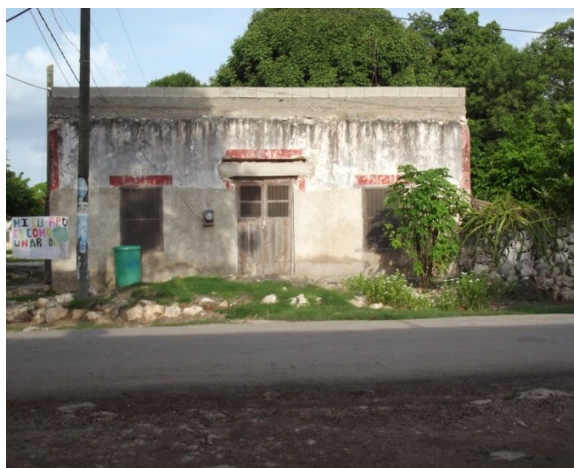
Foto 2. Casa recién mejorada, Programa "Vivienda e infraestructura FHMM" (B. Pech, 2013).
