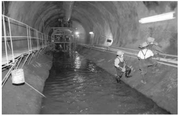
Programa preventivo anual de limpieza y desazolve en red de drenaje -Sacmex
