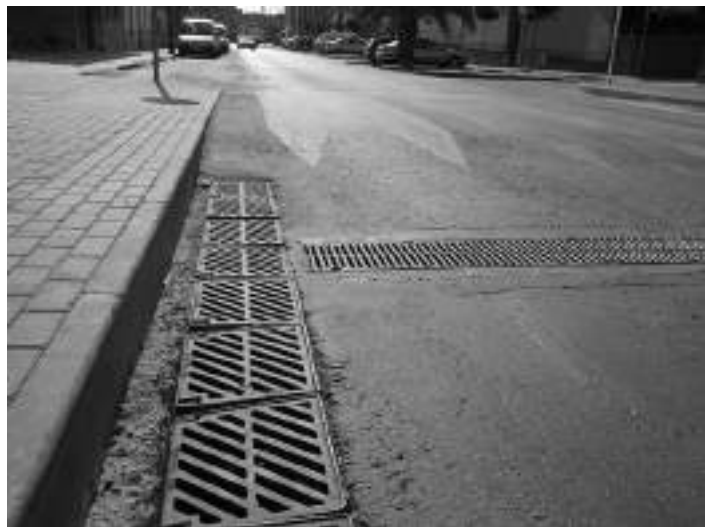
Instalación de alcantarillado existente -Sacmex
