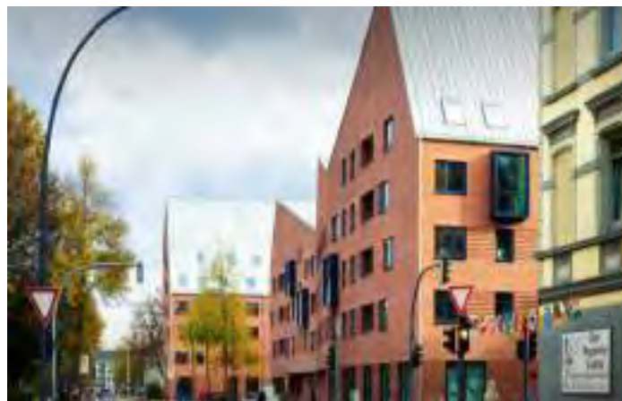
Vista Conjunto -Gerber Architekten
