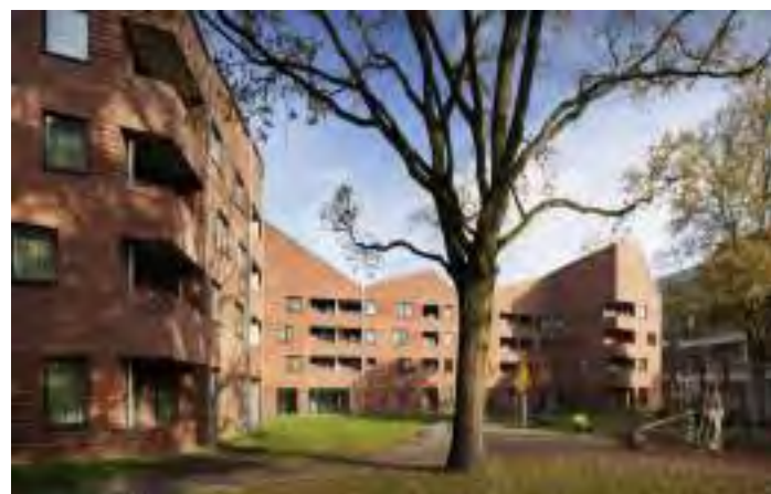
Vista Conjunto -Gerber Architekten
