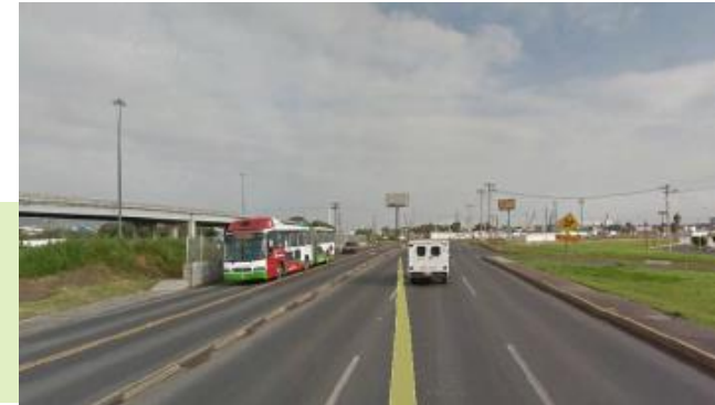
Vista de Avenida Central
