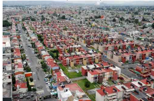
Vista Panorámica Conjunto Ecatepec
