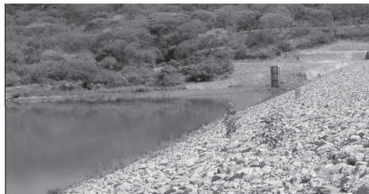
Presa de Cepio de control de aguas pluviales
