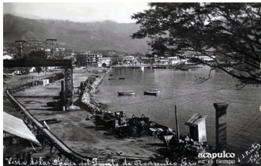
Durante la segunda mitad de la década de los treinta, el fotógrafo José de Jesús Pintos retrata el inicio de las obras del malecón en el puerto.
