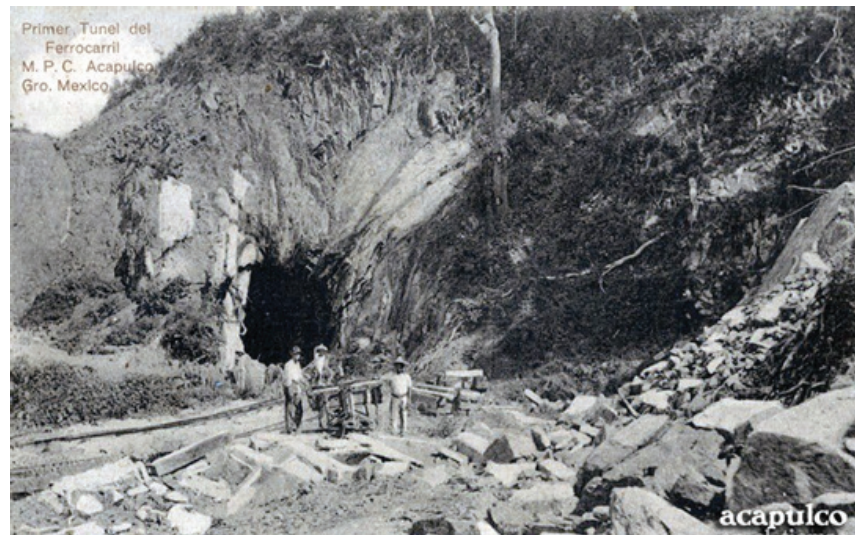
Tres trabajadores posan a principios del siglo XX muy cerca del primer túnel del ferrocarril de la empresa naviera Mexican Pacific Co., en lo que actualmente es la carretera Acapulco-Pie de la Cuesta.
