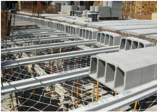
Sistema de vigüeta y bovedilla
