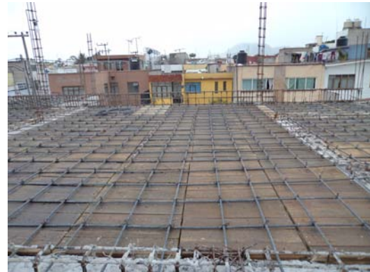
Sistema de losa de concreto armado.
