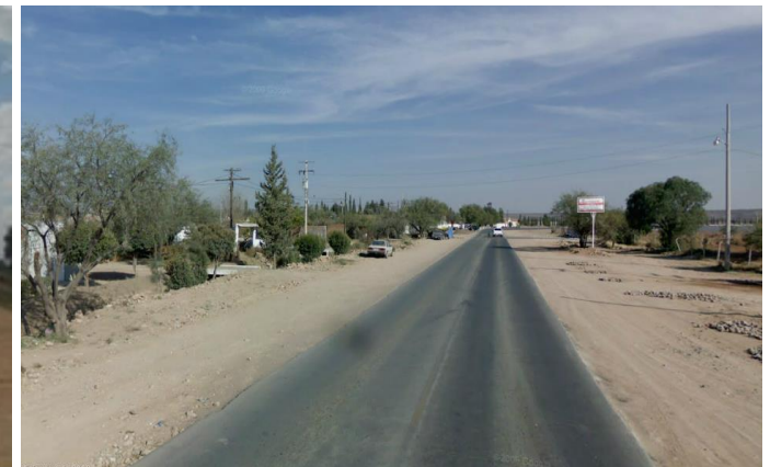
Imagen 6.9 Vista de Av. 5 de Mayo – Carretera Federal 45 Vía Regional.
