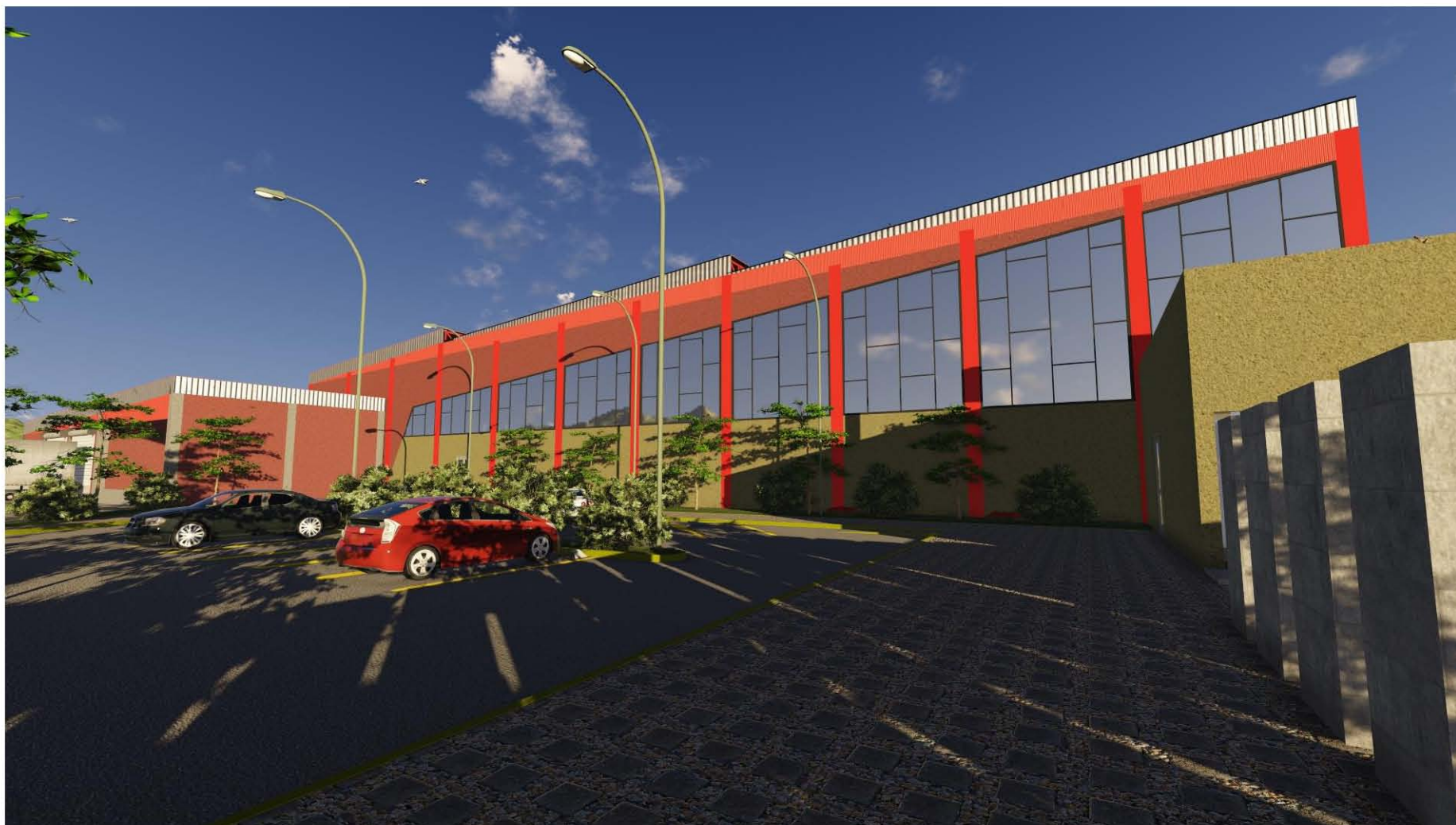
Imagen 8.21 Vista de la nave de acondicionamiento de sustratos desde el estacionamiento.
